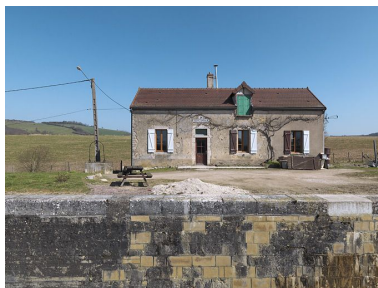
La maison éclusière de face. Puits. Phot. Thierry Kuntz IVR26_20122102706NUC4A
