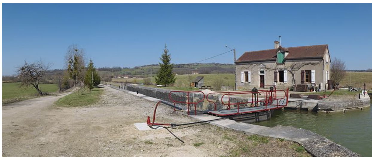
Le site d'écluse vu d'amont.
