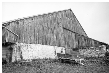
Façade postérieure Phot. Gilbert Poinso IVR43_19752501498Z
