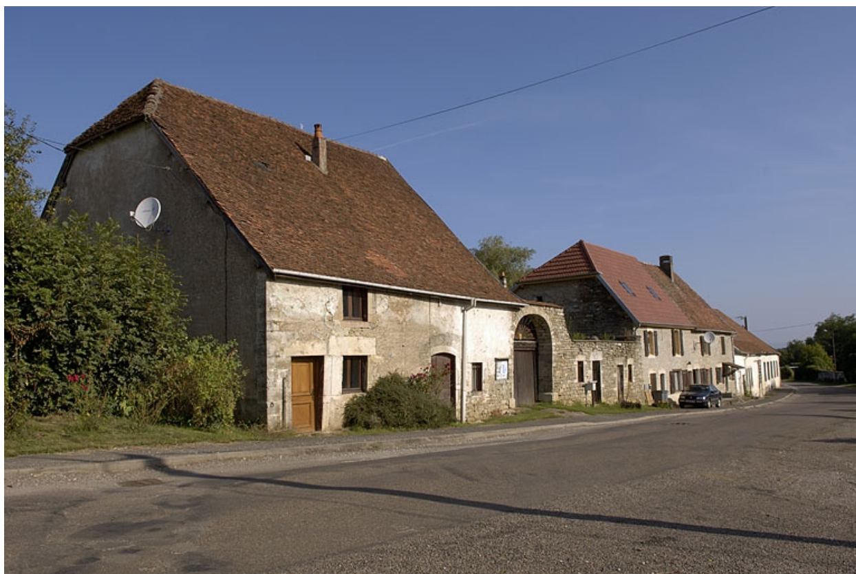
Logements ouvriers vus depuis le sud-est.
