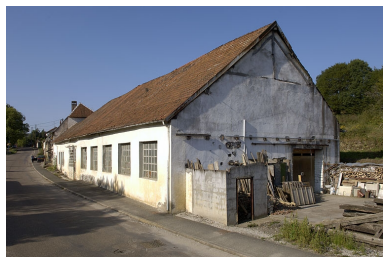
Ancienne halle à charbon. Phot. Jérôme Mongreville IVR43_20057000440NUCA
