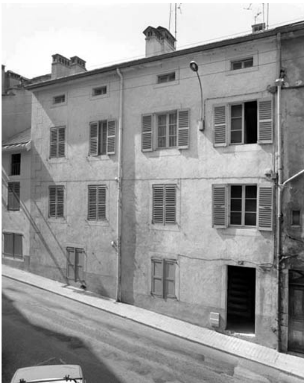
Façade antérieure de l'immeuble.
