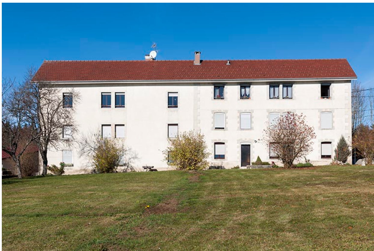
Ferme (à gauche) et atelier (à droite).
