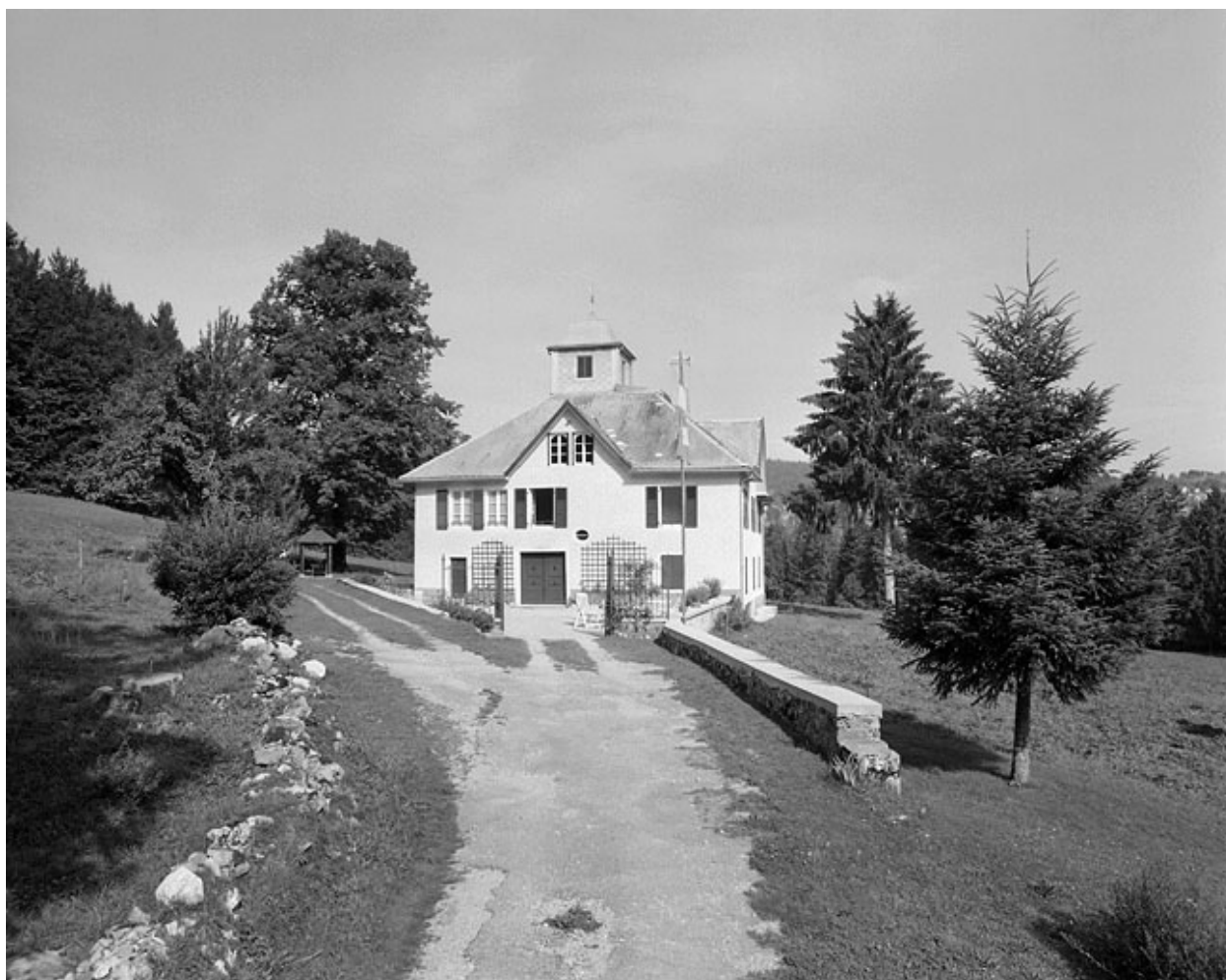
Façade antérieure, vue éloignée.
