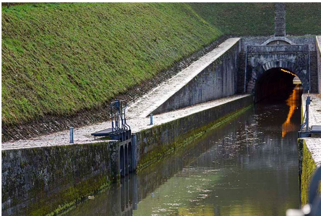
Le tunnel, vue amont.
