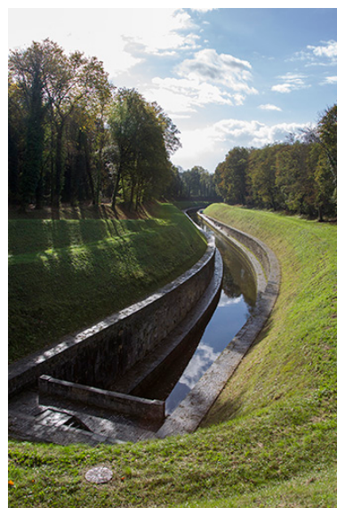
Le canal en aval. Phot. Sonia Dourlot IVR43_20157000223NUC2A
