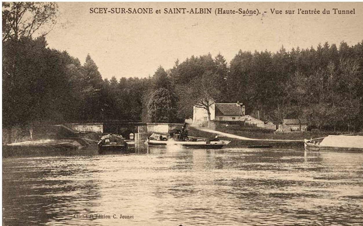
Vue sur l'entrée du Tunnel, carte postale.
