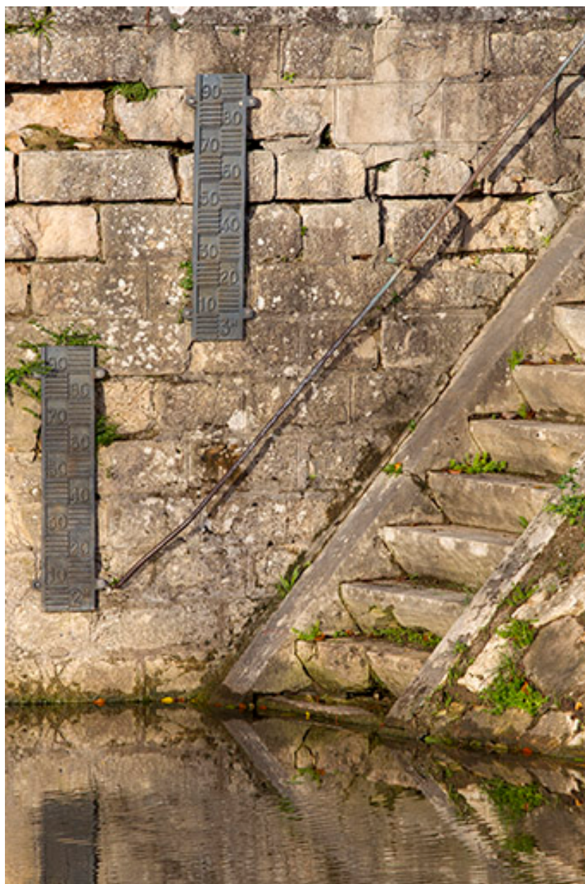
Echelles limnimétriques , porte de garde.
