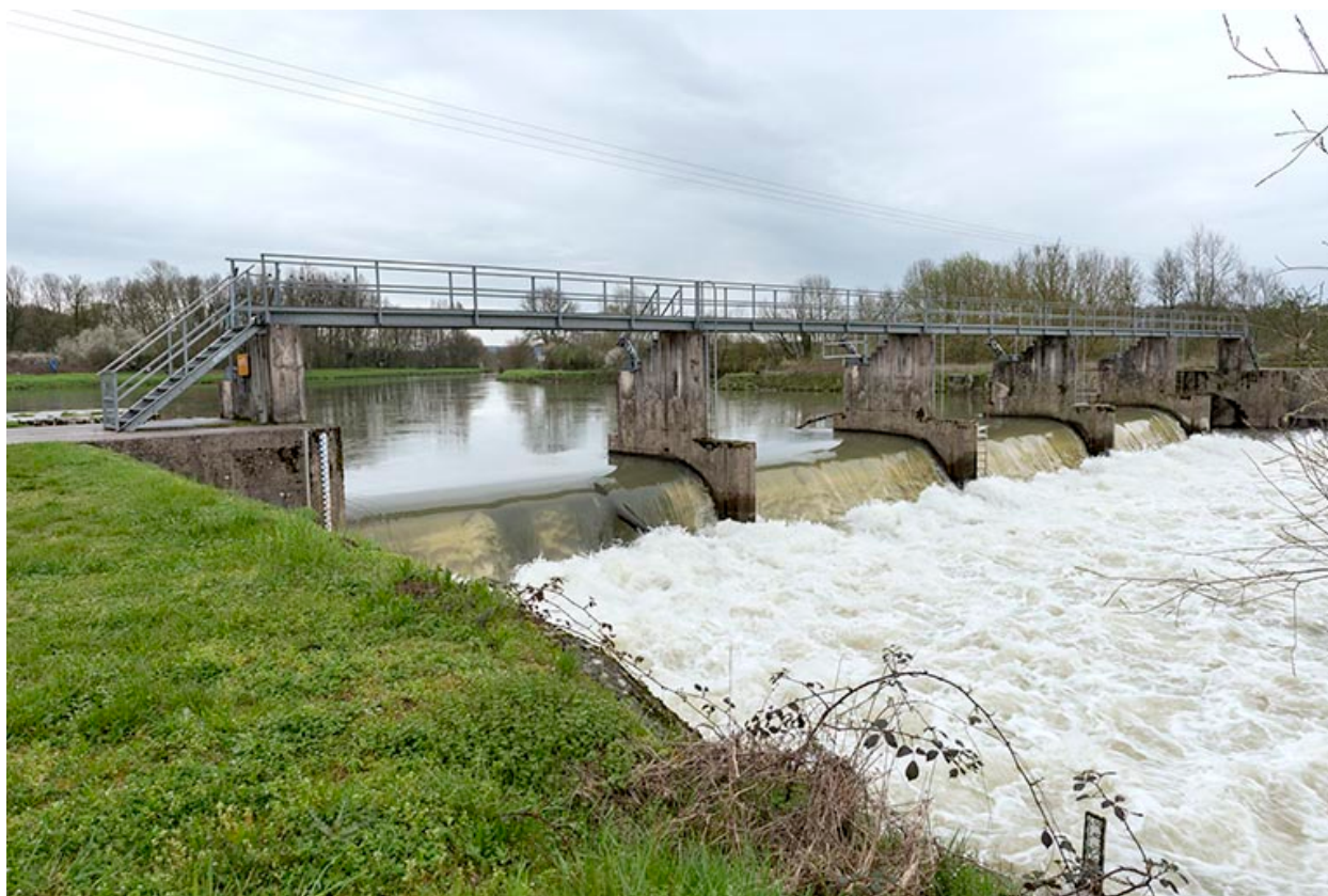
Le barrage mobile de Saint-Albin.
