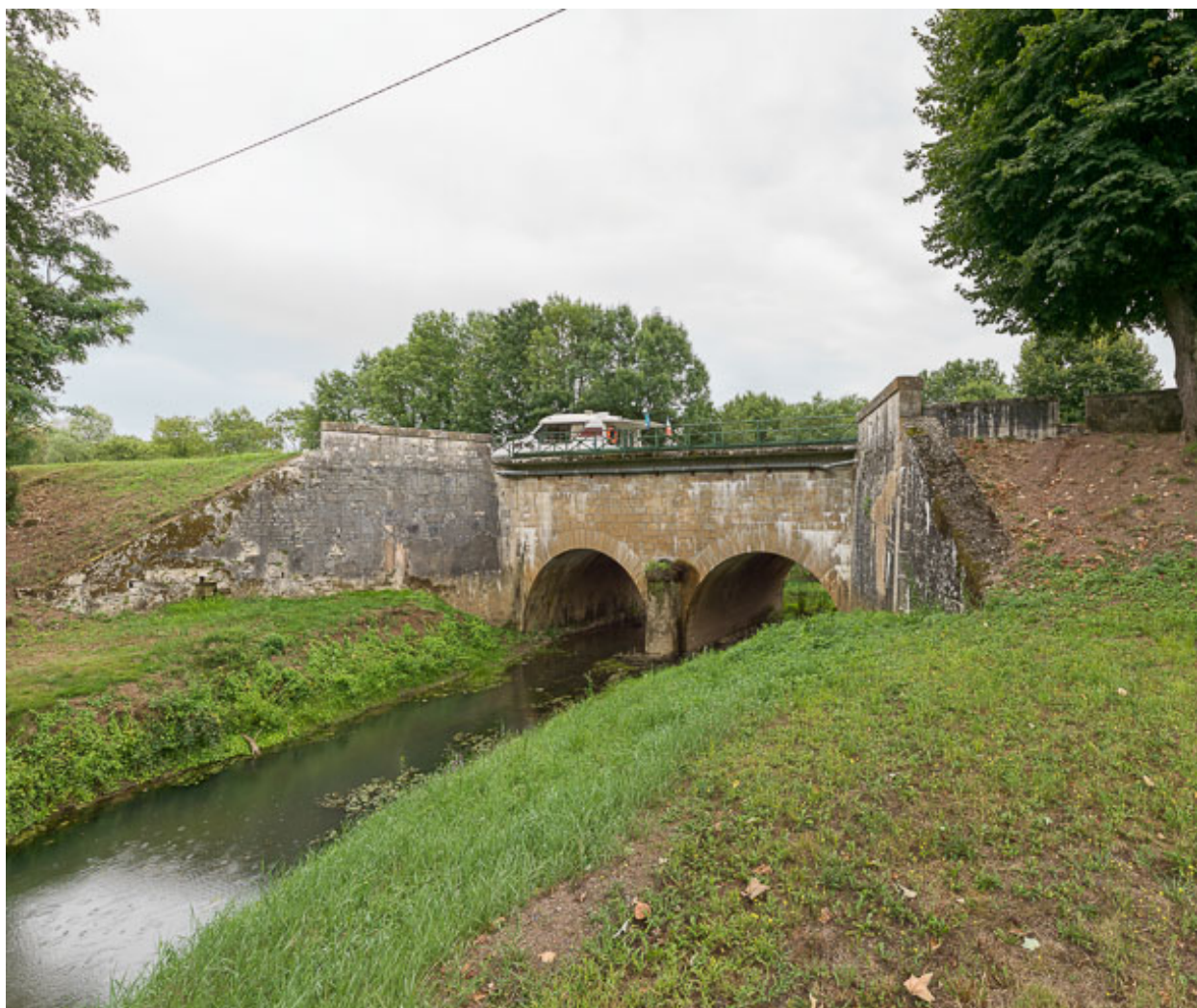
Vue d'ensemble, rive droite.
