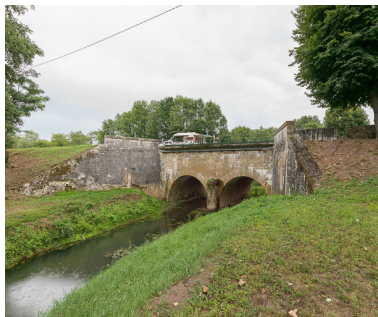
Vue d'ensemble, rive droite. Phot. Pierre-Marie Barbe-Richaud IVR26_20175800220NUC2AQ
