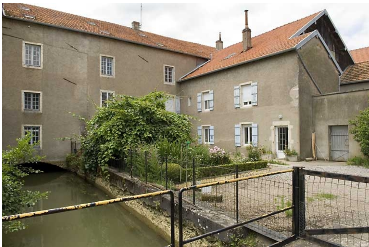
Façade postérieure et canal d'amenée.
