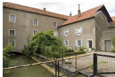
Façade postérieure et canal d'amenée. Phot. Jérôme Mongreville IVR43_20087000694NUC2A
