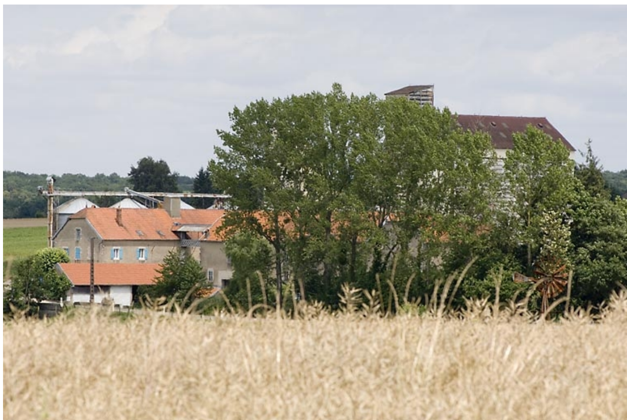
Vue rapprochée depuis le sud-ouest.
