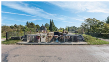
Le double sas vu du pont. Phot. Pierre-Marie Barbe-Richaud IVR26_20128900603NUC4AQ
