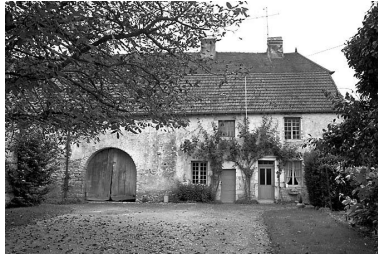
Façade antérieure. Phot. Dominique Dominguez IVR43_19807000180X
