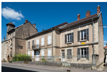
Élévation sur la rue Armand- Paulmard, vue de trois quarts. Phot. Jérôme Mongreville IVR43_20187000434NUC4A
