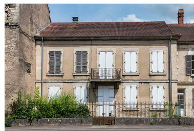
Élévation sur la rue Armand- Paulmard, vue de face. Phot. Jérôme Mongreville IVR43_20187000437NUC4A
