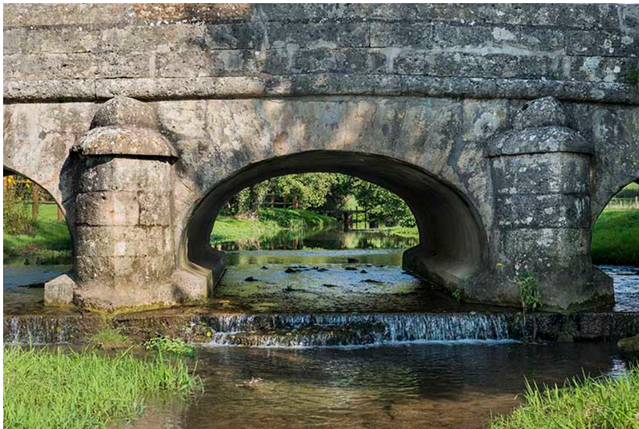
La voûte centrale.
