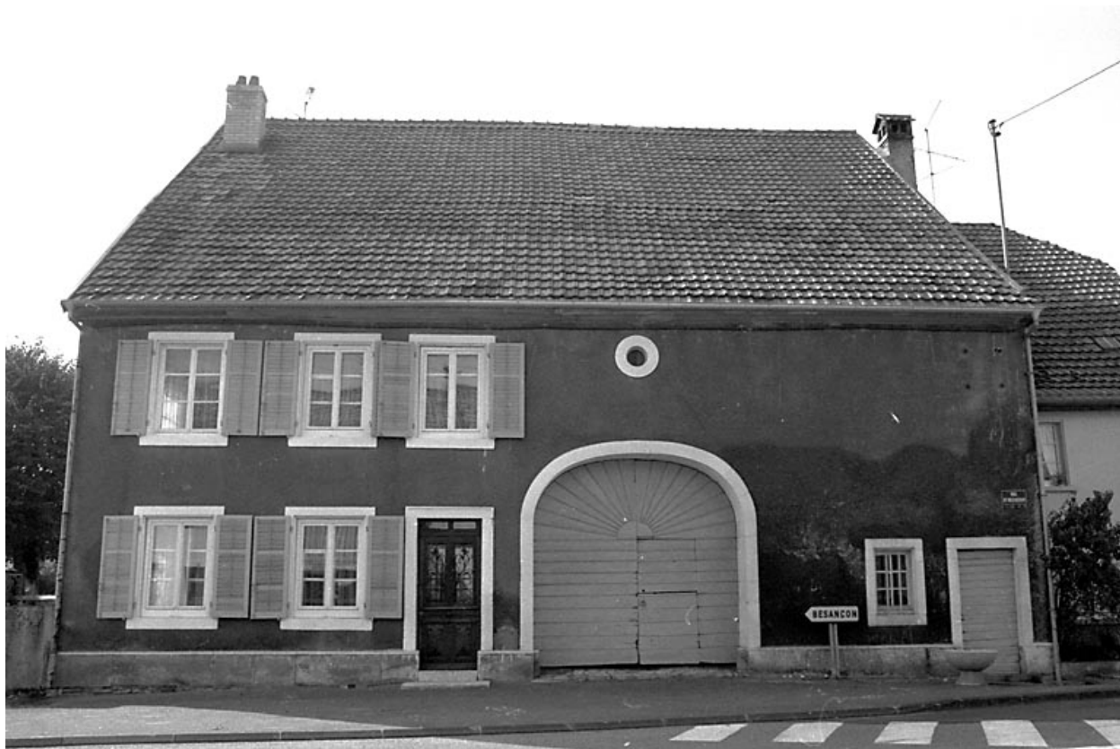
Ferme située 2 rue de Voujeaucourt.
