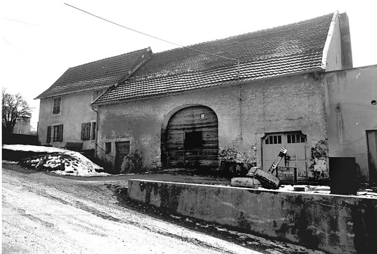
Montbouton : ferme située 11 Grande Rue.
