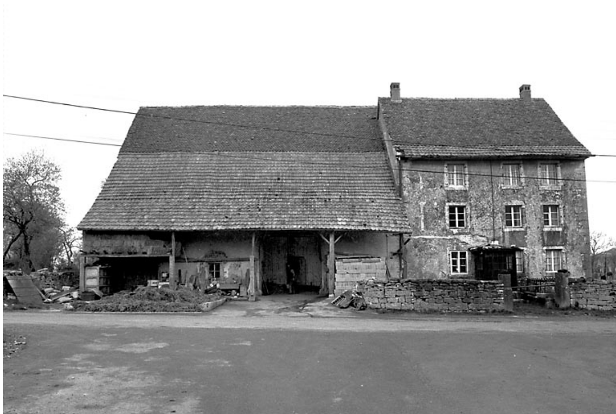
Croix : ferme située 33 rue Principale.
