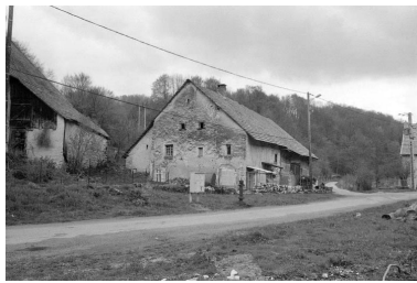
Saint-Dizier-l'Evêque : ferme située rue de Villars-le-Sec. Phot. Bernard Lardière IVR43_19829000311Z
