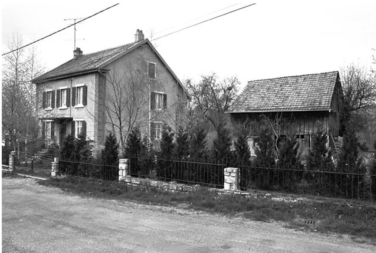
Fêche-l'Eglise : maison située rue du Doubs.
