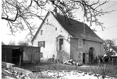
Montbouton : maison située 18 rue du Mont Novel. Phot. Bernard Lardière IVR43_19829000246Z
