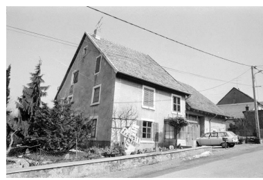
Beaucourt : maison située 23 rue de la Maison Blanche. Phot. Bernard Lardière IVR43_19829000249Z
