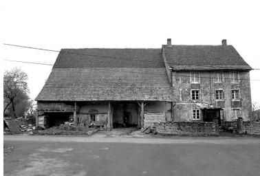
Croix : ferme située 33 rue Principale. Phot. Bernard Lardière IVR43_19829000198Z
