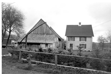
Croix : ferme située rue Principale. Phot. Bernard Lardière IVR43_19829000203Z
