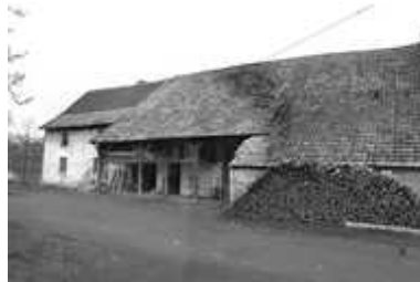
Croix : ferme située rue Derrière les Murs. Phot. Bernard Lardière IVR43_19829000197Z
