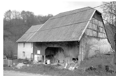
Saint-Dizier l'Evêque : ferme dont l'habitation est en moellons enduits et la partie agricole en pans de bois et torchis. (AE1). Phot. Bernard Lardière IVR43_19829000313Z
