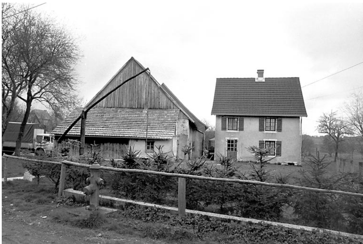
Croix : ferme située rue Principale.
