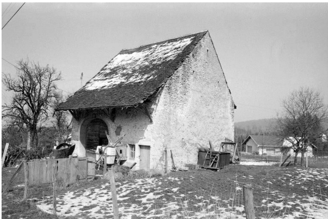
Edifice agricole à Montbouton.
