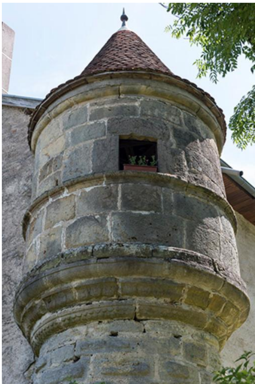
Détail de l'échauguette de l'ancienne écurie
