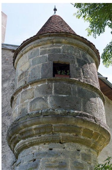
Détail de l'échauguette de l'ancienne écurie Phot. Sonia Dourlot IVR43_20167001274NUC4A
