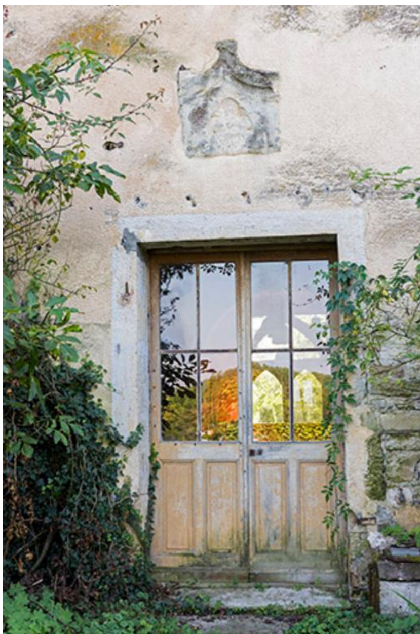
Entrée au rez-de-chaussée du donjon, côté Nord-Est
