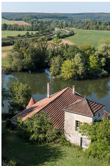
Vue des bâtiments de la basse- cour en bordure de Saône Phot. Sonia Dourlot IVR43_20167001267NUC4A
