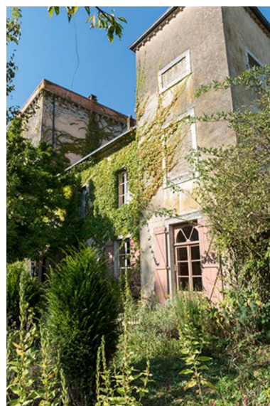
Aile du château côté Sud-Ouest Phot. Sonia Dourlot IVR43_20167001294NUC4A
