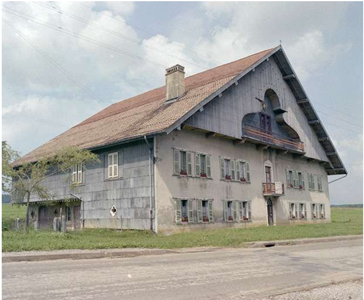
Façades antérieure et latérale gauche.
