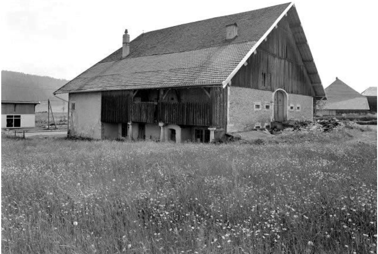
Façades postérieure et latérale droite.
