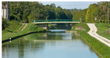
Vue du pont. Phot. Pierre-Marie Barbe-Richaud IVR26_20112104117NUC4AQ
