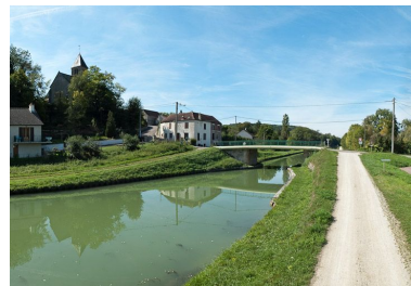
Vue du pont. Phot. Pierre-Marie Barbe-Richaud IVR26_20112104122NUC2AQ
