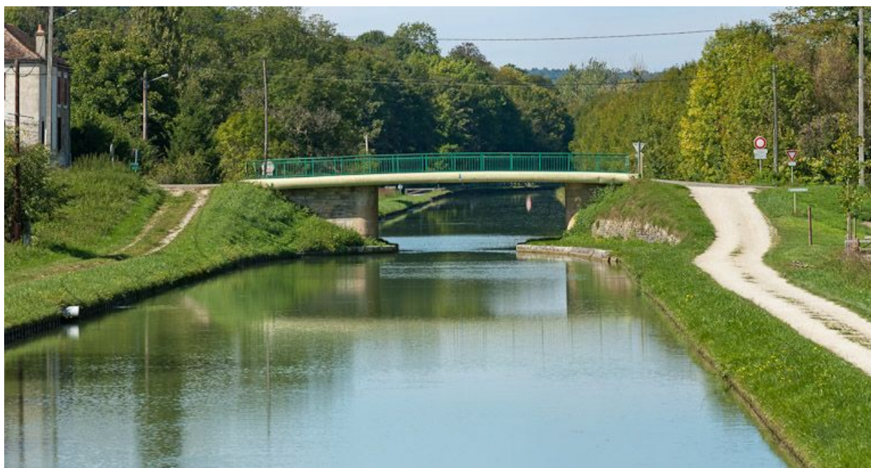
Vue du pont.
