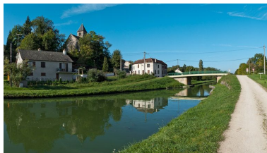
Vue générale du pont et de son environnement. Phot. Pierre-Marie Barbe-Richaud IVR26_20112104135NUC4AQ
