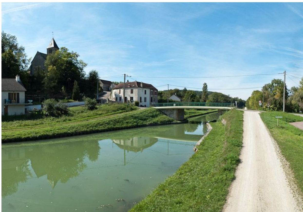
Vue du pont.
