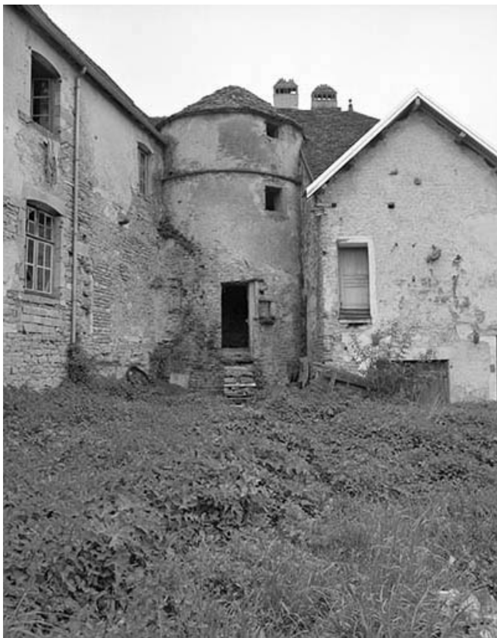
Façade ouest, partie gauche.
