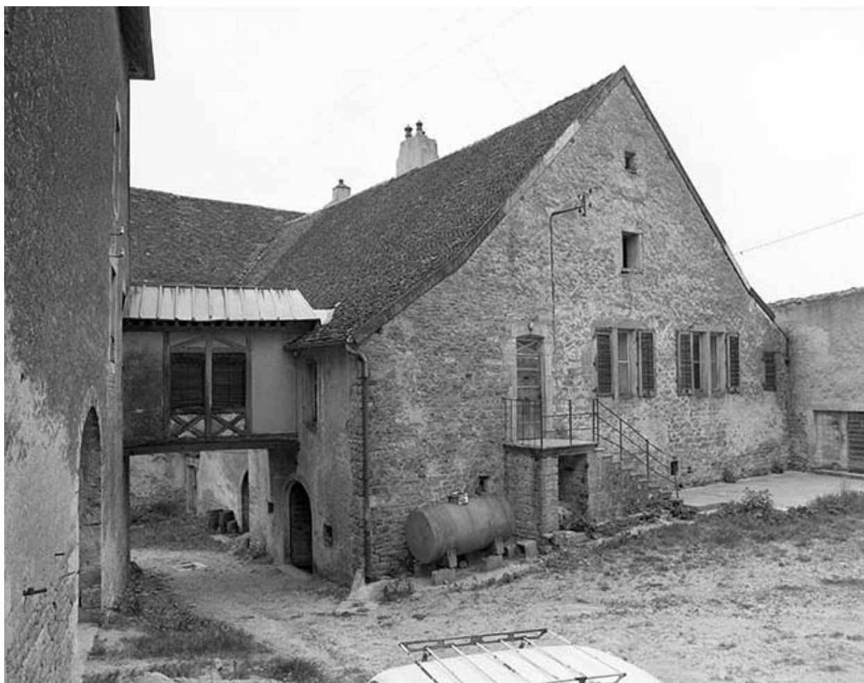
Façade est, partie droite.
