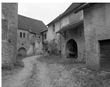
Cour côtés nord et est. Phot. Yves Sancey IVR43_19813900180X
