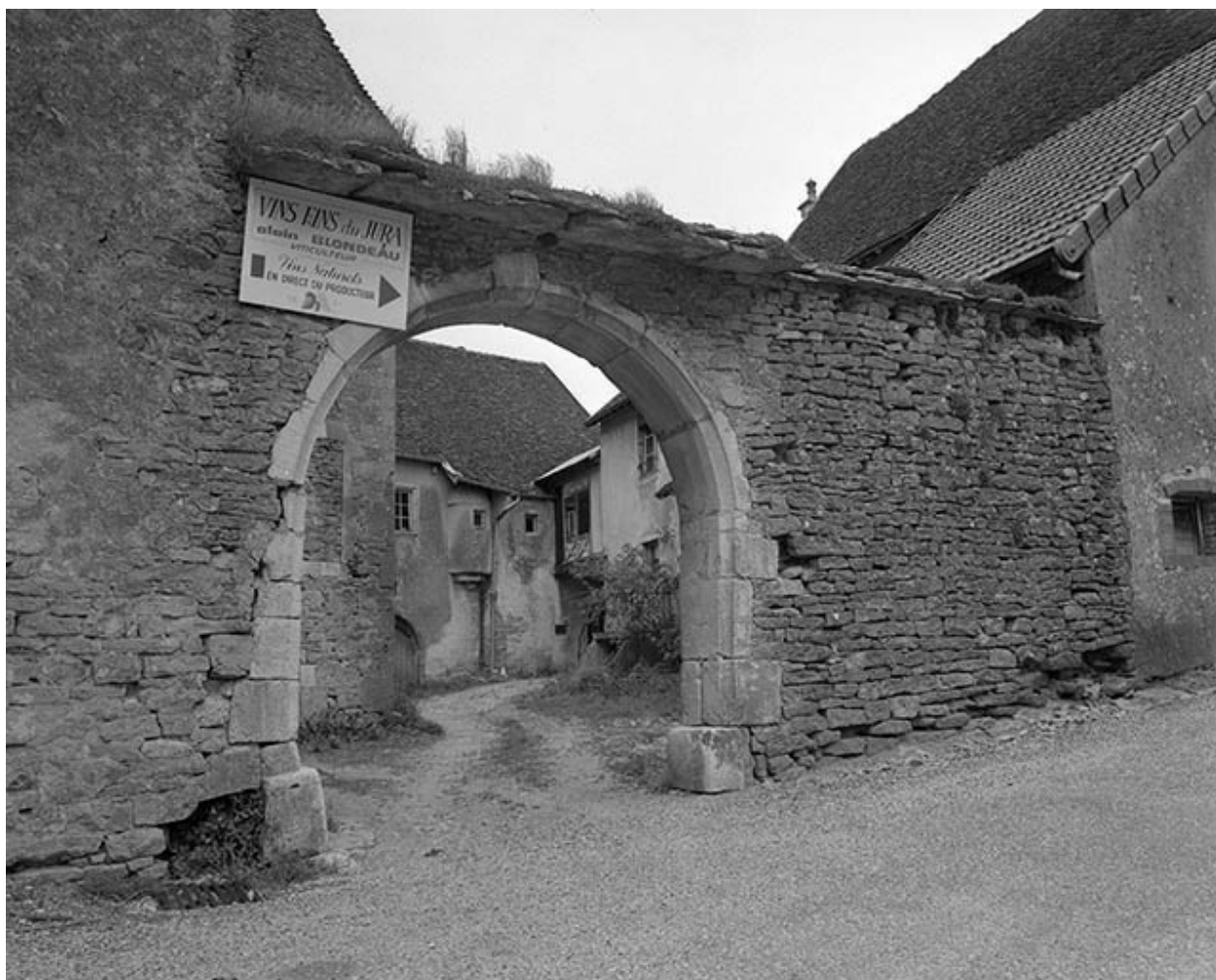
Façade sud : portail d'entrée de la cour.
