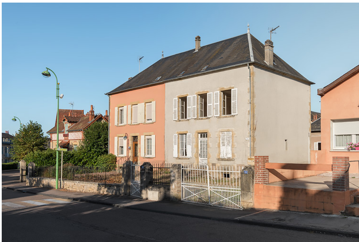
Façade sur l'actuelle avenue Eugène Collin.
