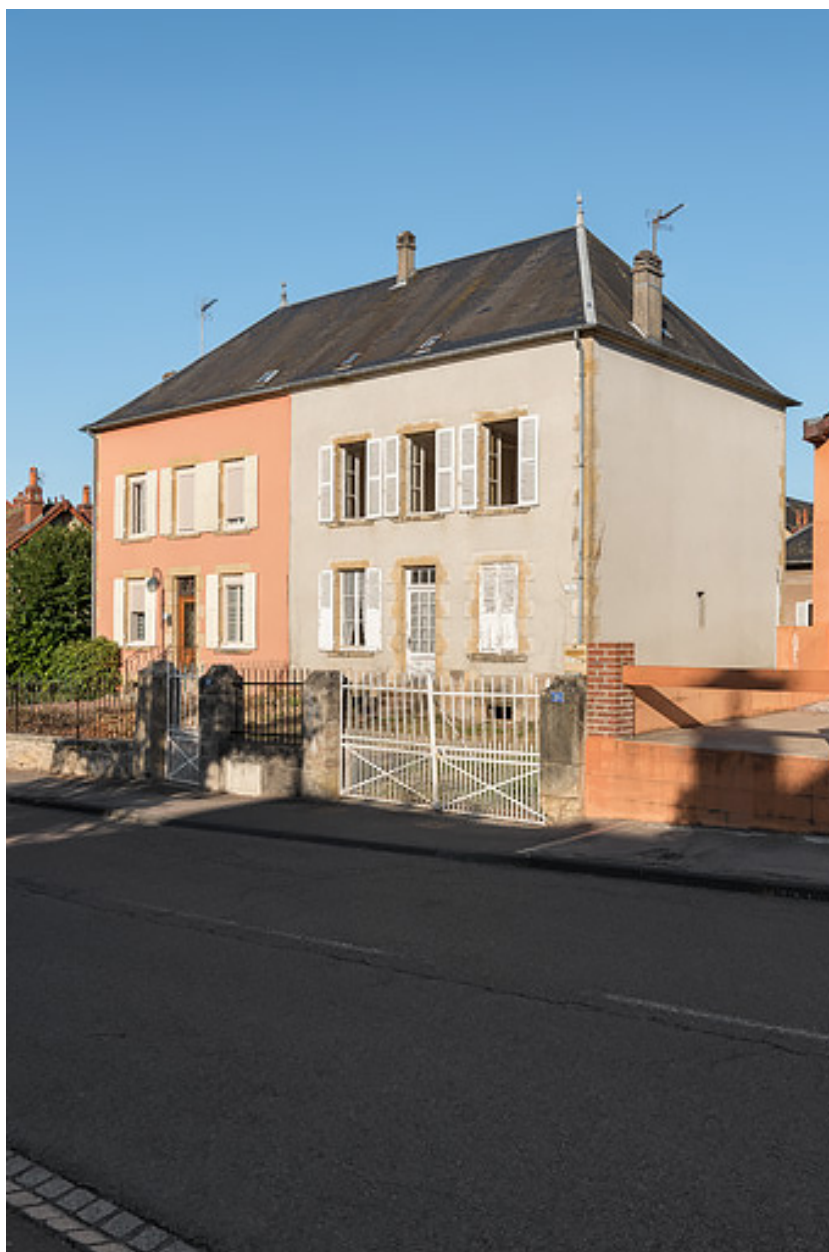
Façade sur l'actuelle avenue Eugène Collin.
