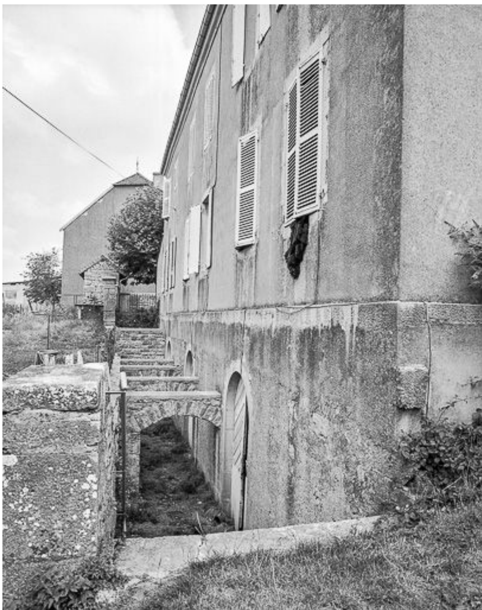
Détail du soubassement de la façade postérieure.
