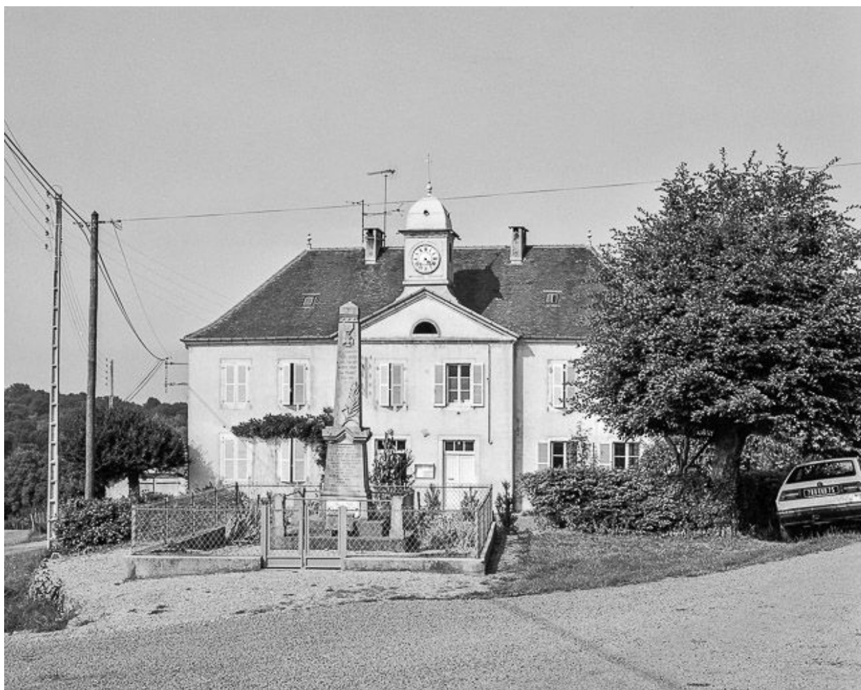
Façade antérieure vue de face.
