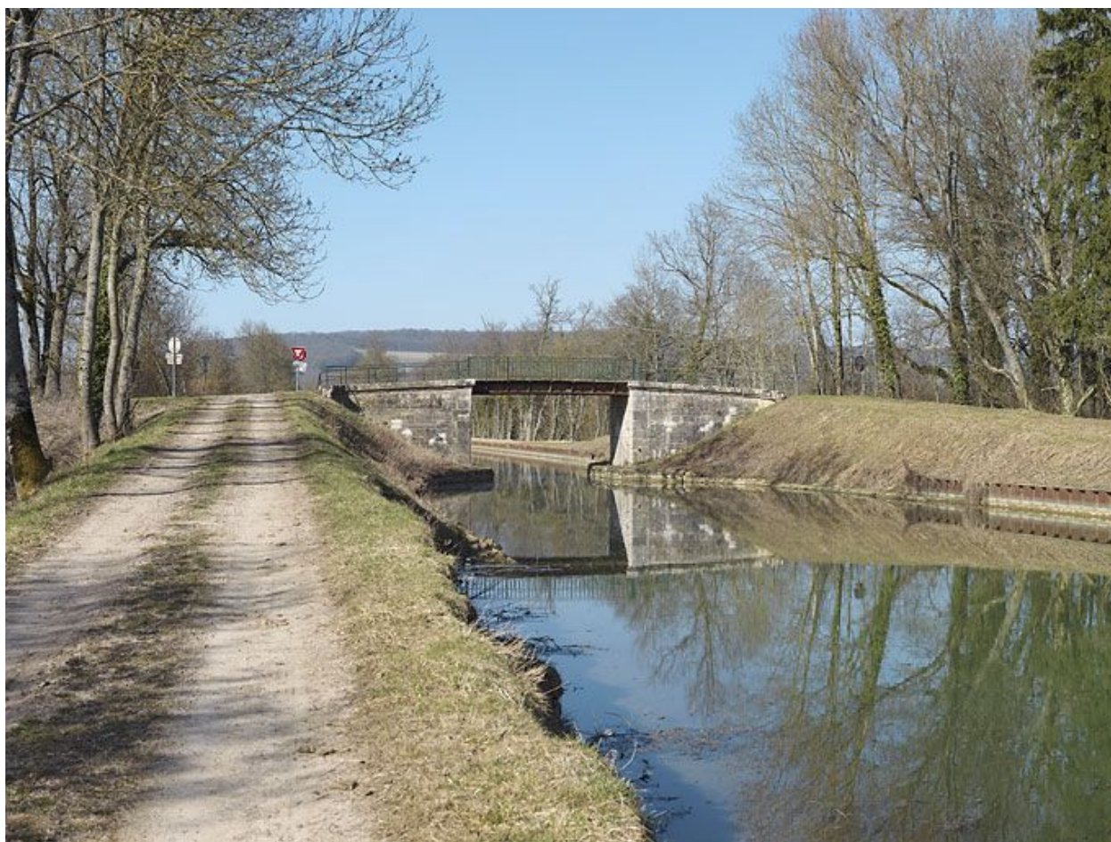
Le pont vu d'amont.
