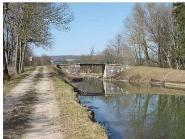
Le pont vu d'amont.
