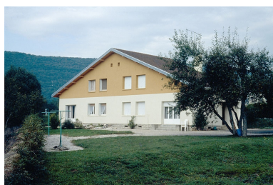
Maison d'agent de maîtrise : façade antérieure. Phot. Jérôme Mongreville IVR43_19913900708ZA
