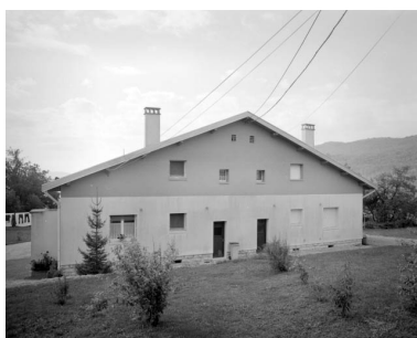
Maison d'agent de maîtrise : façade postérieure. Phot. Jérôme Mongreville IVR43_19913900709X
