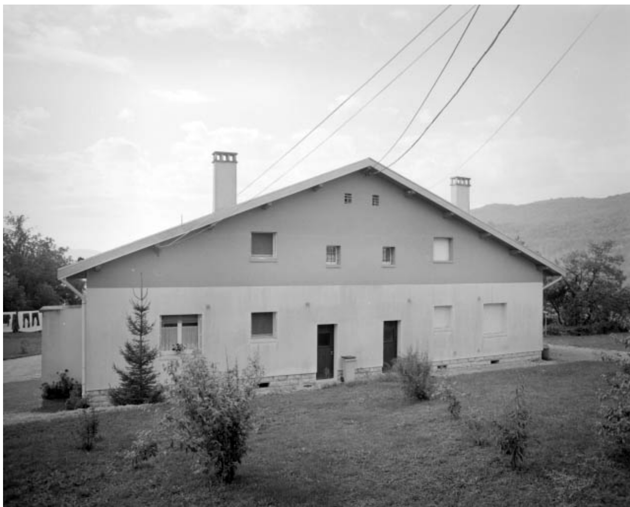
Maison d'agent de maîtrise : façade postérieure.
