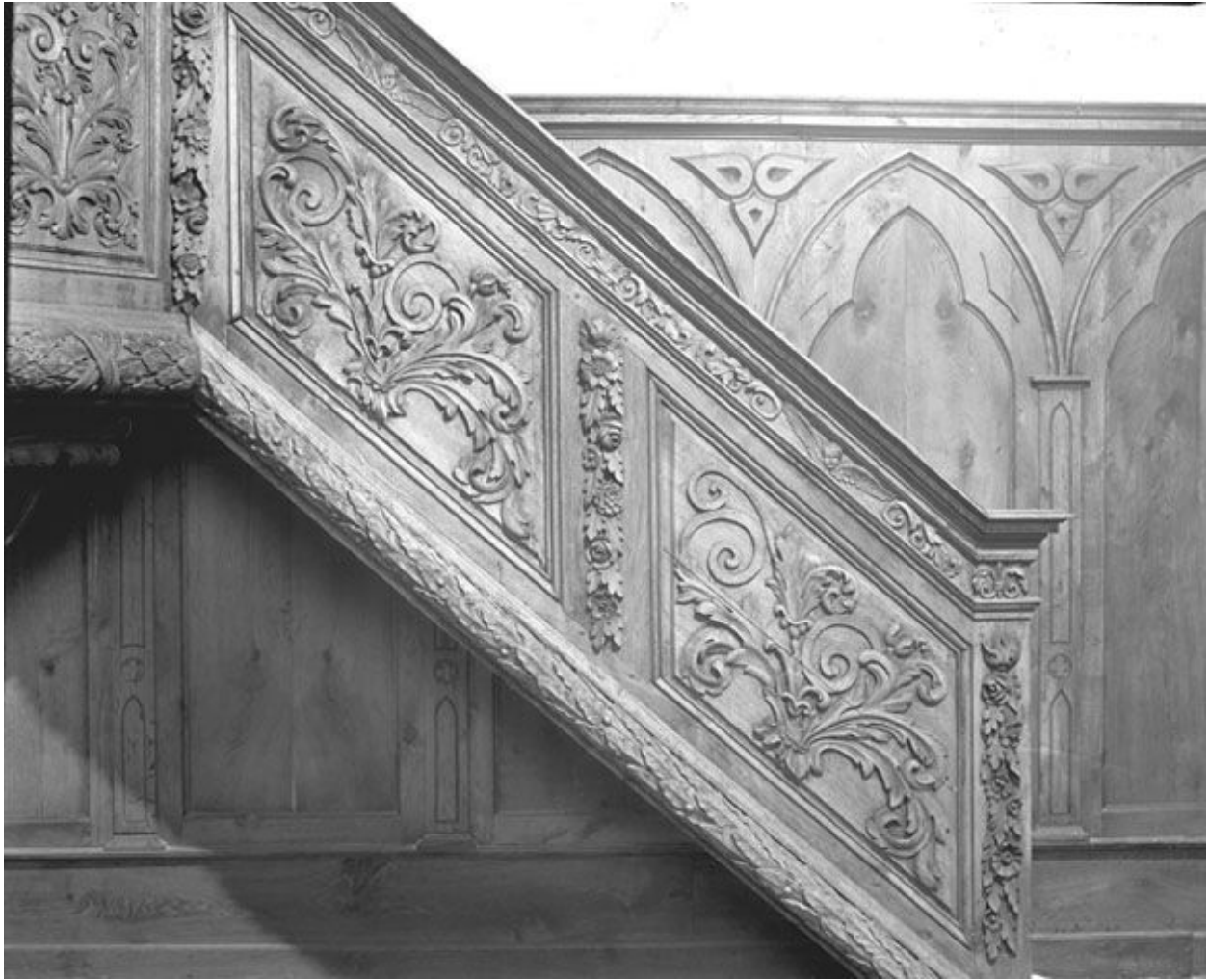
Panneaux de la rampe.
