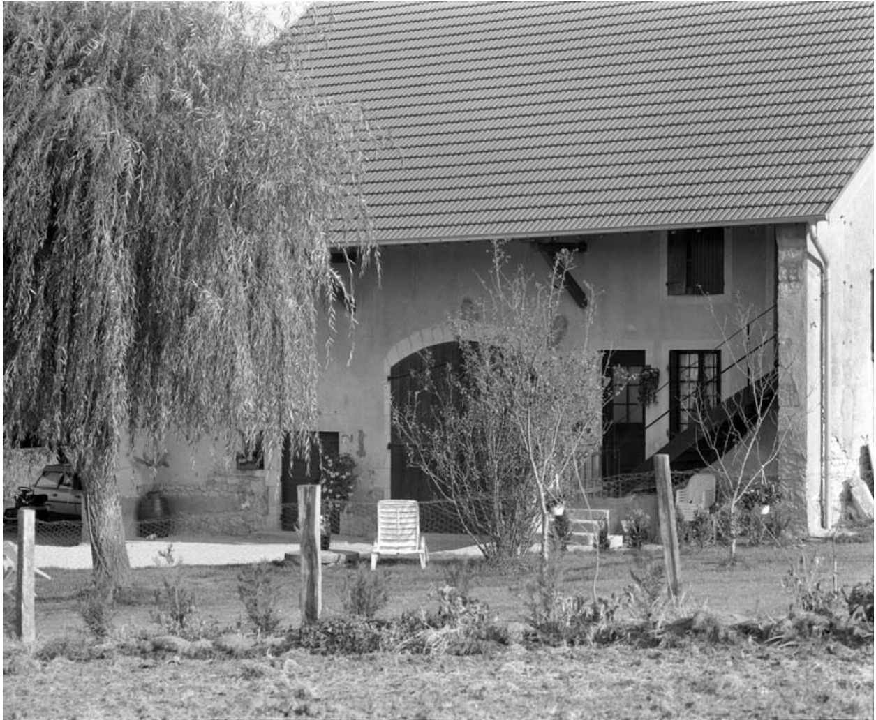
Vue de la façade antérieure de face.
