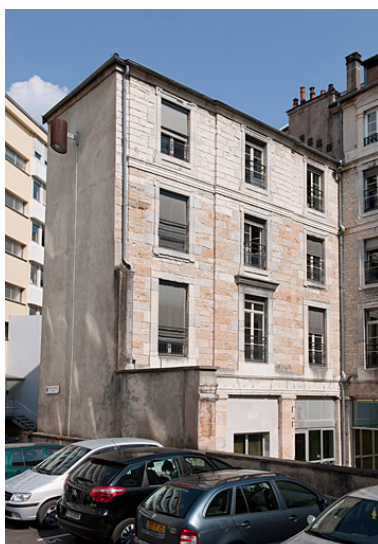
Vue d'ensemble de l'aile gauche sur cour.
