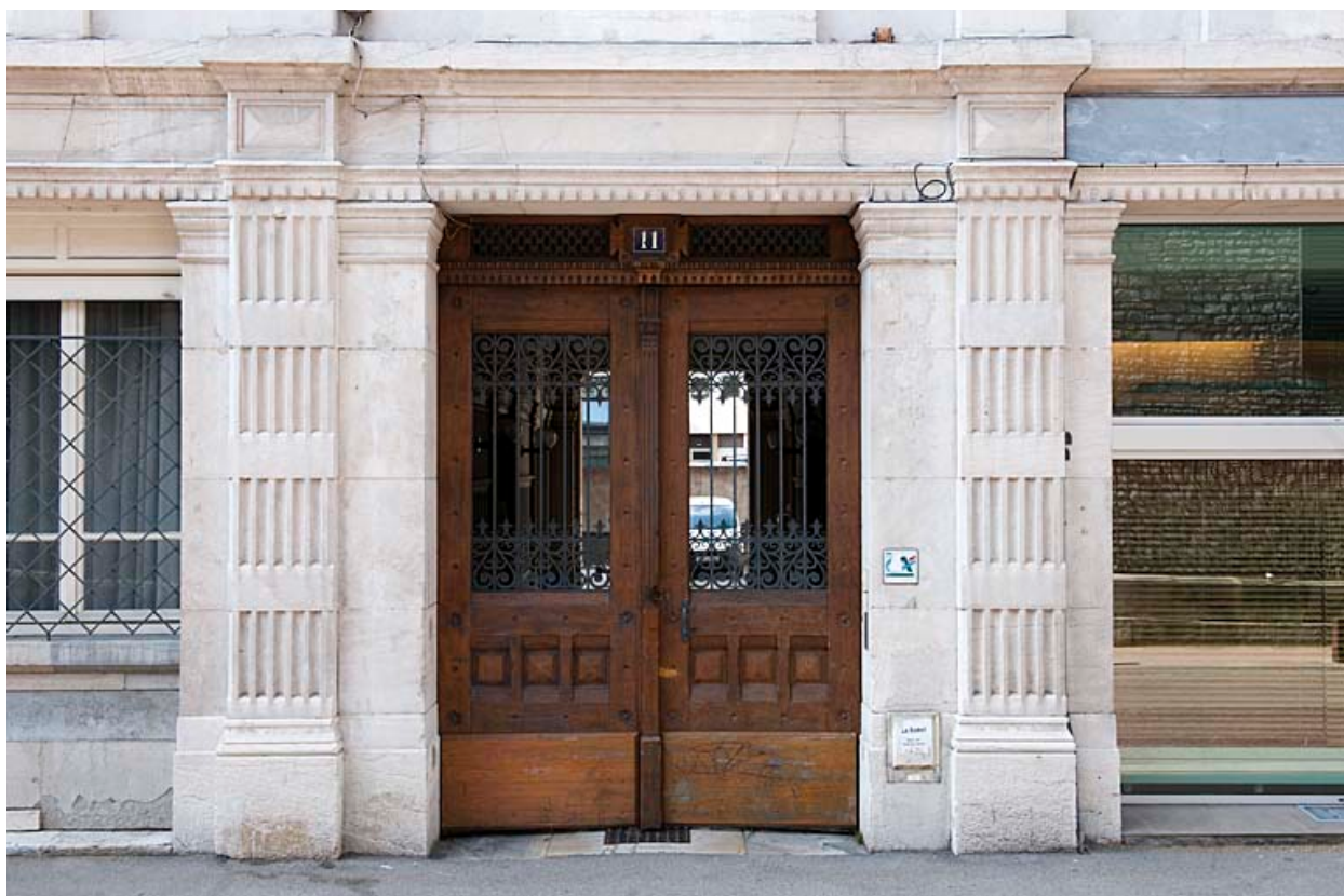
Façade sur rue : détail de l'entrée cochère.
