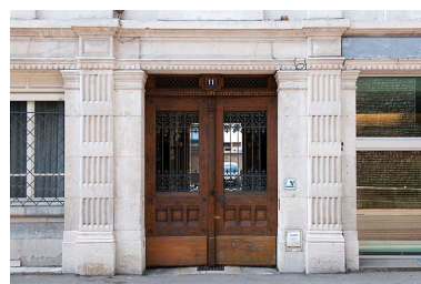
Façade sur rue : détail de l'entrée cochère.
