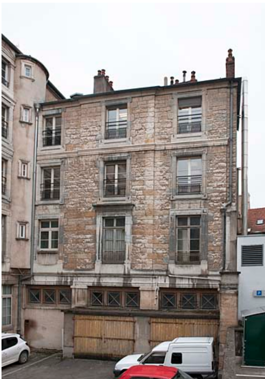
Détail de l'aile droite sur cour.
