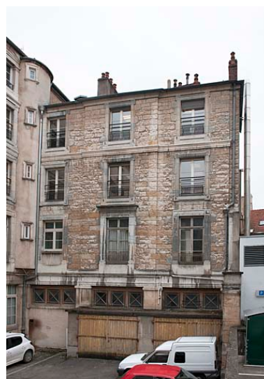
Détail de l'aile droite sur cour.
