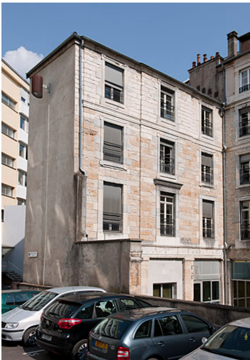
Vue d'ensemble de l'aile gauche sur cour.
