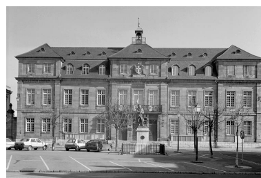
Façade principale. Phot. Jérôme Mongreville IVR43_19882500025V
