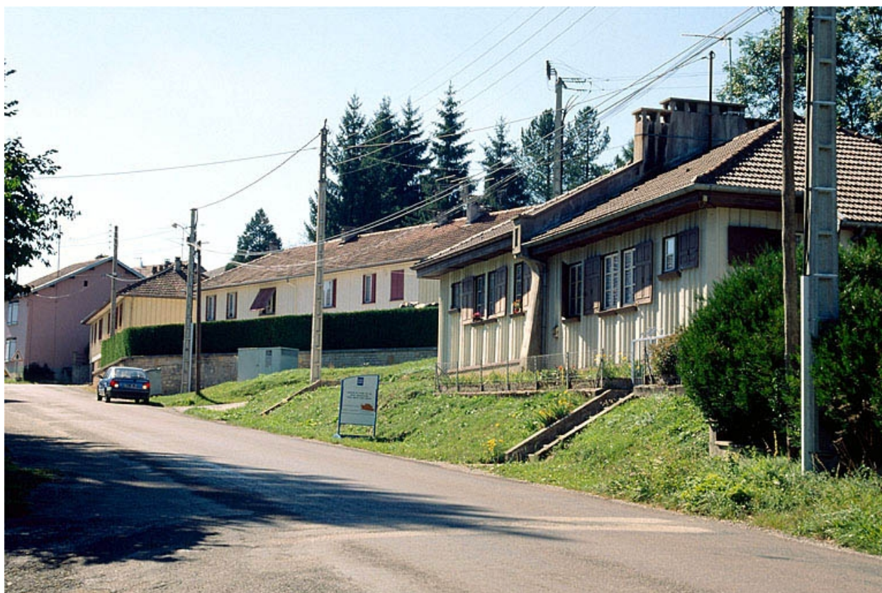
Vue d'ensemble des logements depuis l'est.
