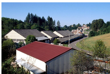
Vue d'ensemble depuis la voie ferrée. Phot. Yves Sancey IVR43_19973901380ZA
