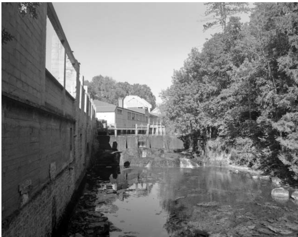
Façades de l'usine sur l'Angillon et barrage.
