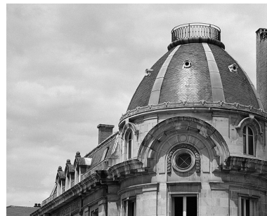
Détail du dôme. Phot. Yves Sancey IVR43_19917000404X
