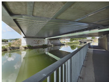
Vue du dessous du tablier. Phot. Thierry Kuntz IVR26_20112102978NUC4A
