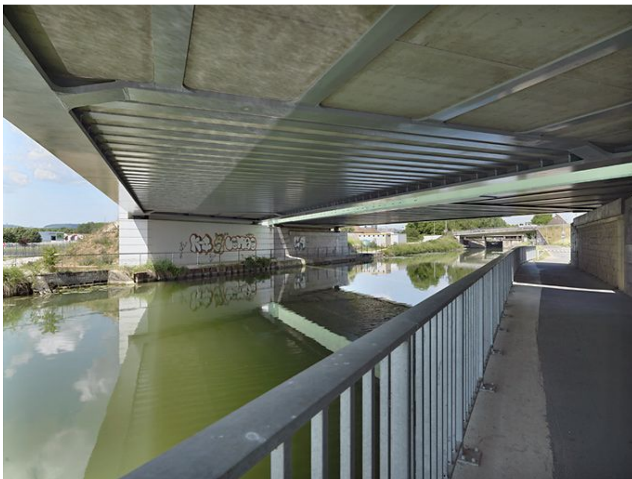
Vue du dessous du tablier.
