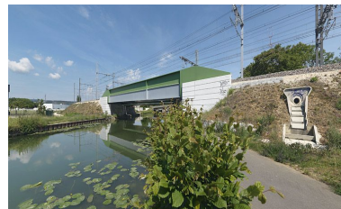
Vue d'ensemble d'aval. Phot. Thierry Kuntz IVR26_20112102981NUC4A
