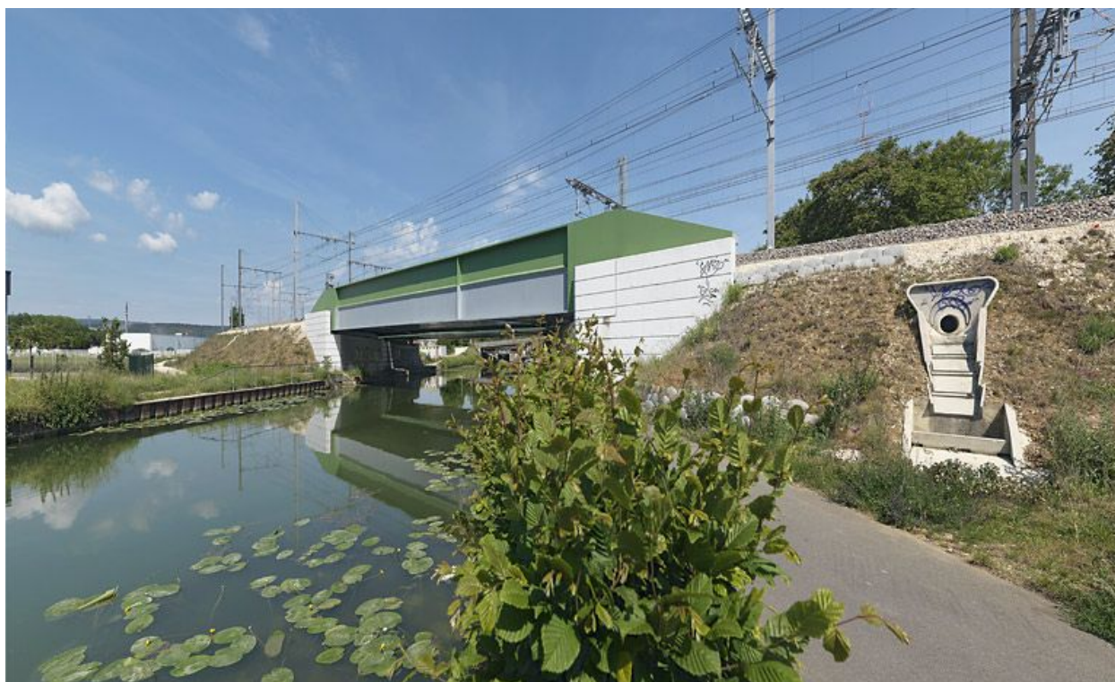
Vue d'ensemble d'aval.
