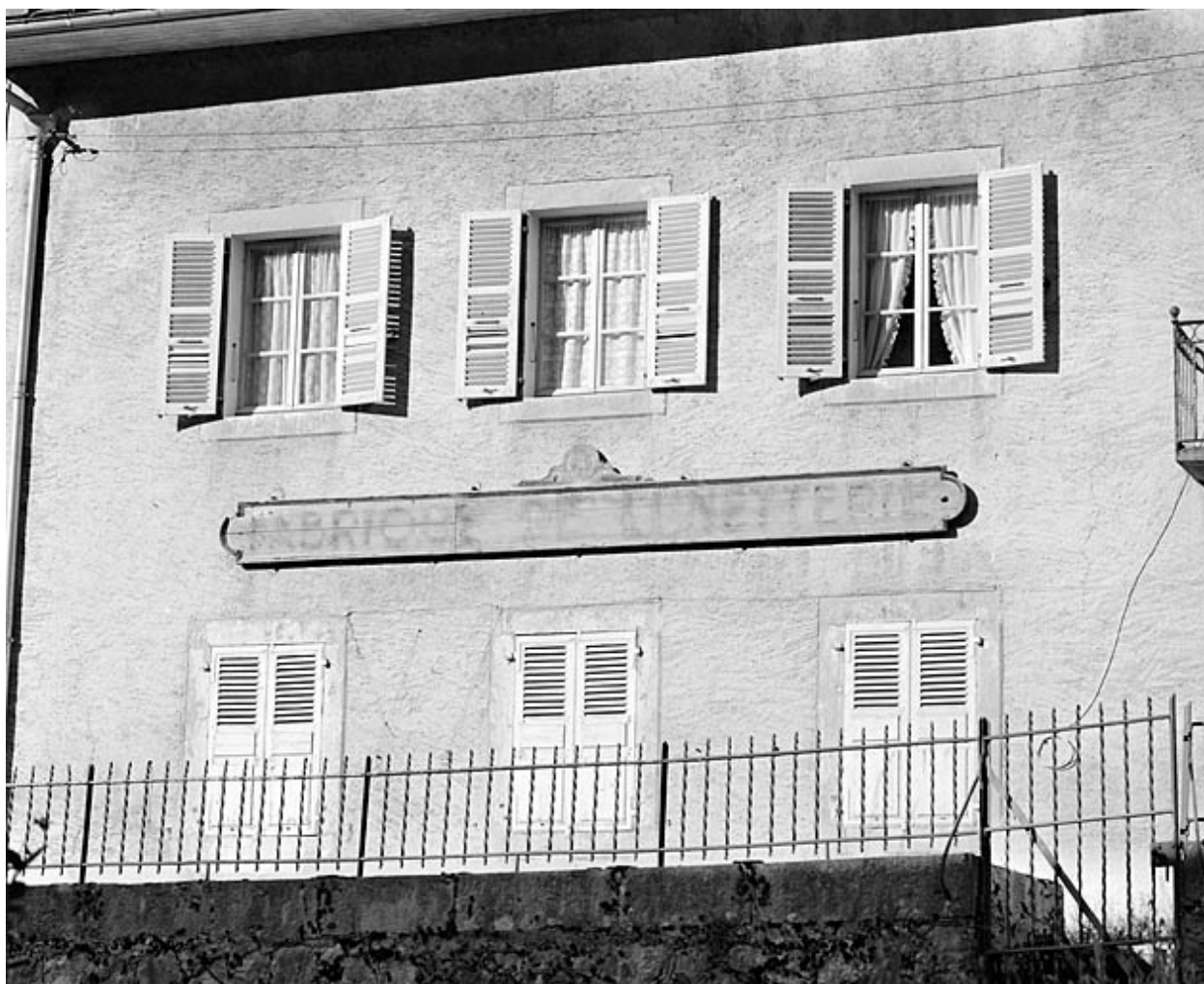
Maison : enseigne sur l'élévation latérale droite.
