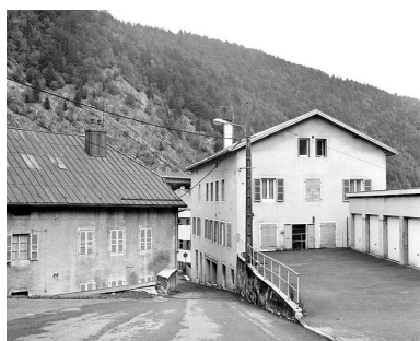
Immeuble : élévation occidentale.
