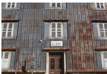
Maison : essentage de tôle sur l'élévation antérieure. Phot. Yves Sancey IVR43_20103900537NUC2A
