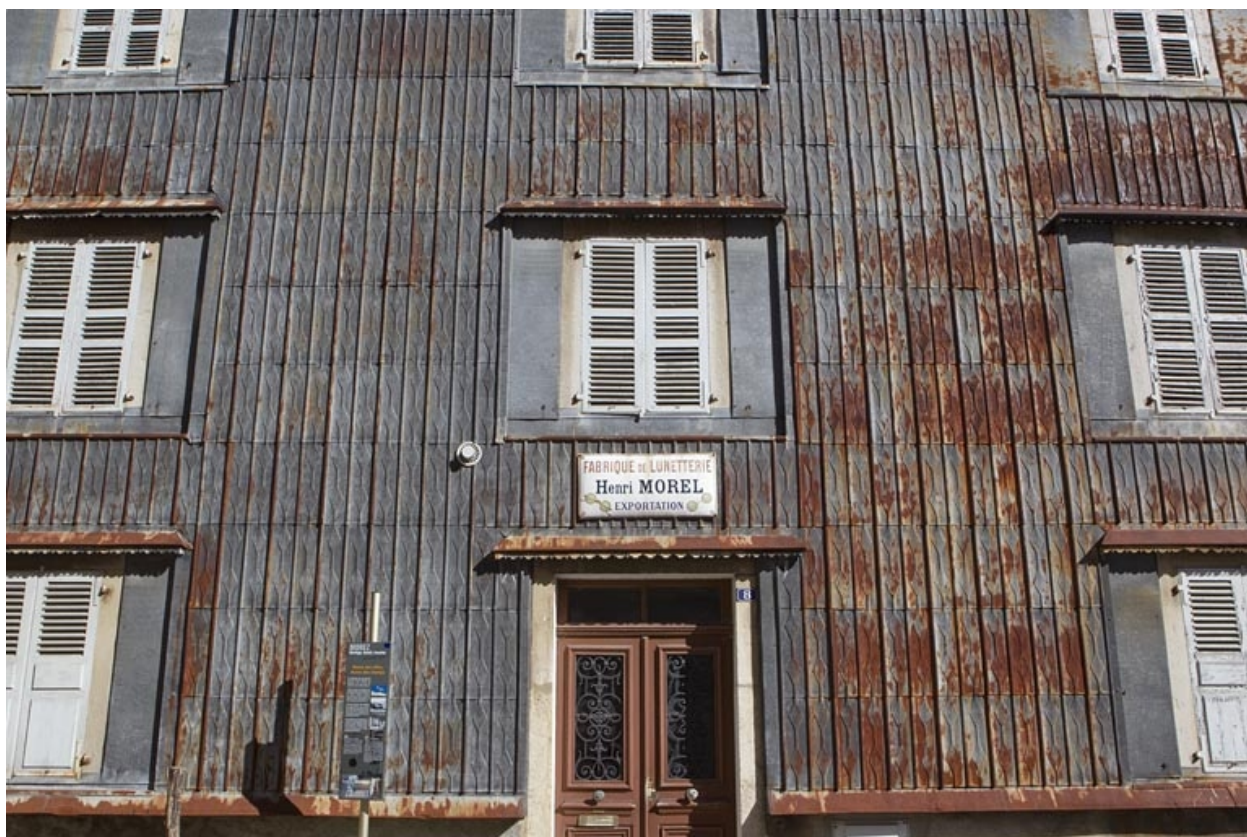
Maison : essentage de tôle sur l'élévation antérieure.
