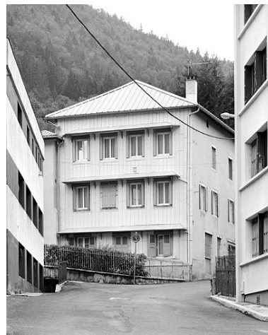
Immeuble : élévation orientale.
