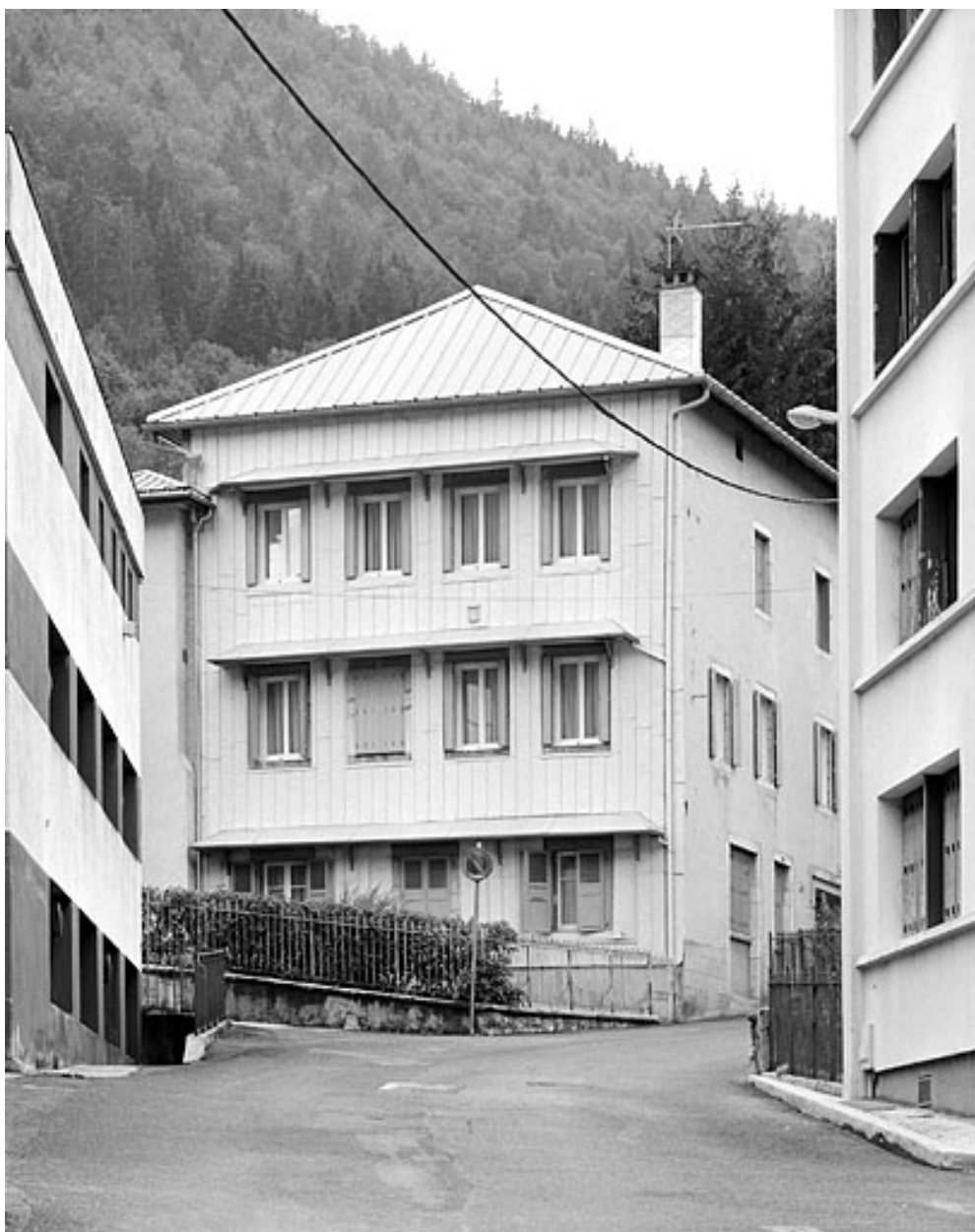
Immeuble : élévation orientale.
