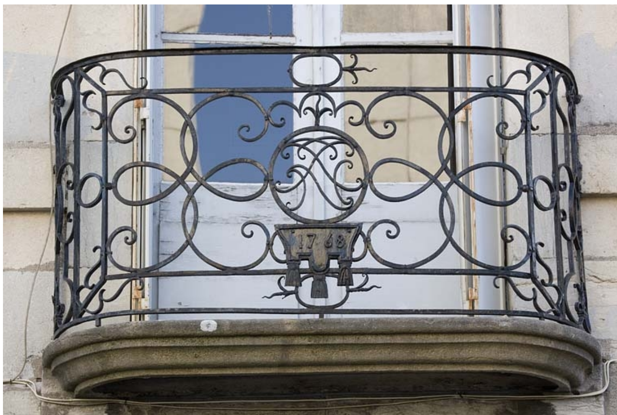
Détail du balcon : vue rapprochée.
