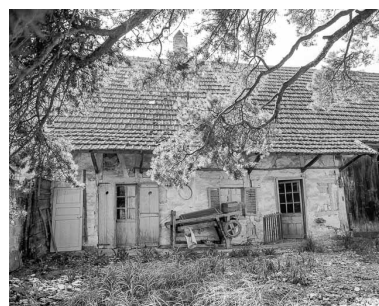
Façade antérieure : partie gauche. Phot. Dominique Dominguez IVR43_19773900108X
