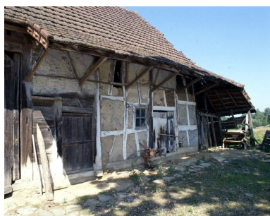
Façade antérieure : partie droite en pan de bois et en brique. Phot. Yves Sancey IVR43_19903901149XA
