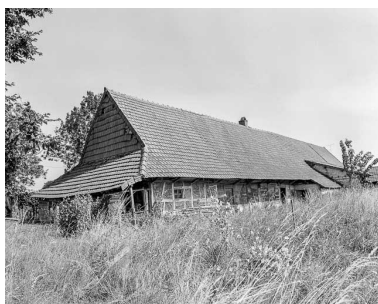
Façade postérieure et côté gauche. Phot. Dominique Dominguez IVR43_19773900109X
