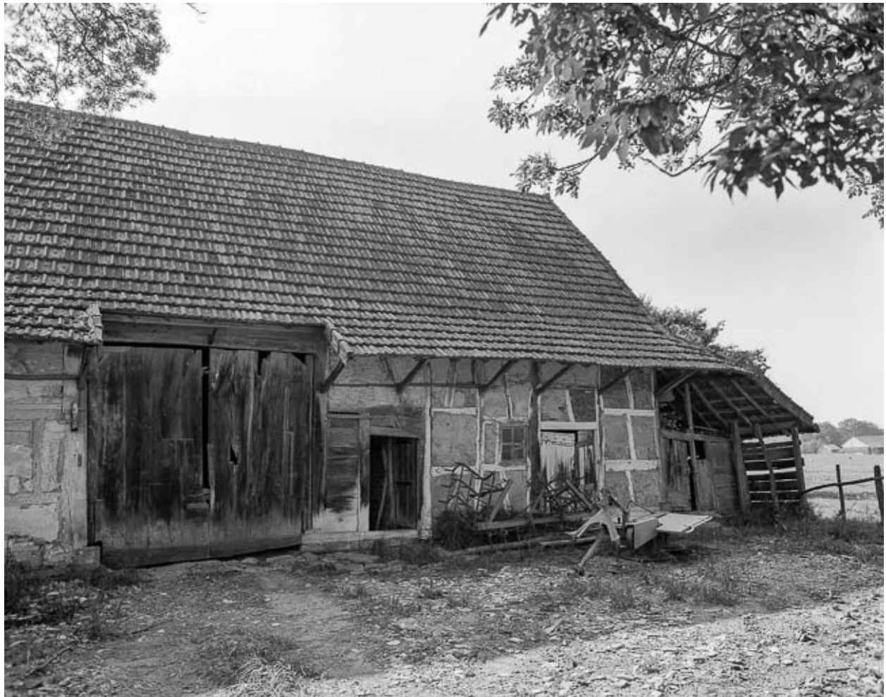
Façade antérieure : partie droite.
