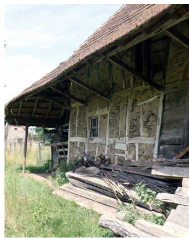
Façade postérieure en pan de bois et en brique. Phot. Yves Sancey IVR43_19903901150XA
