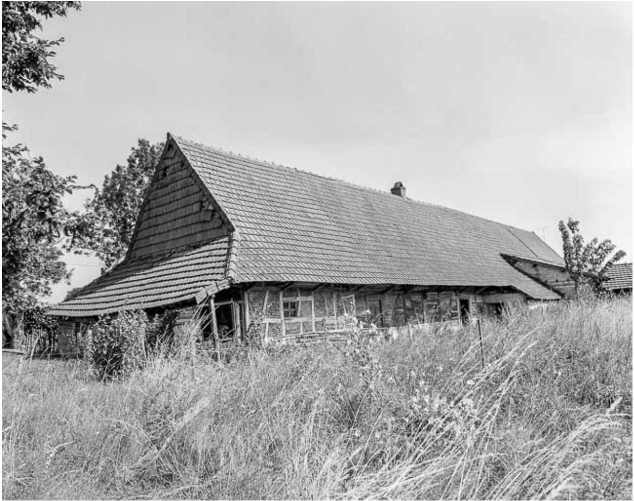
Façade postérieure et côté gauche.
