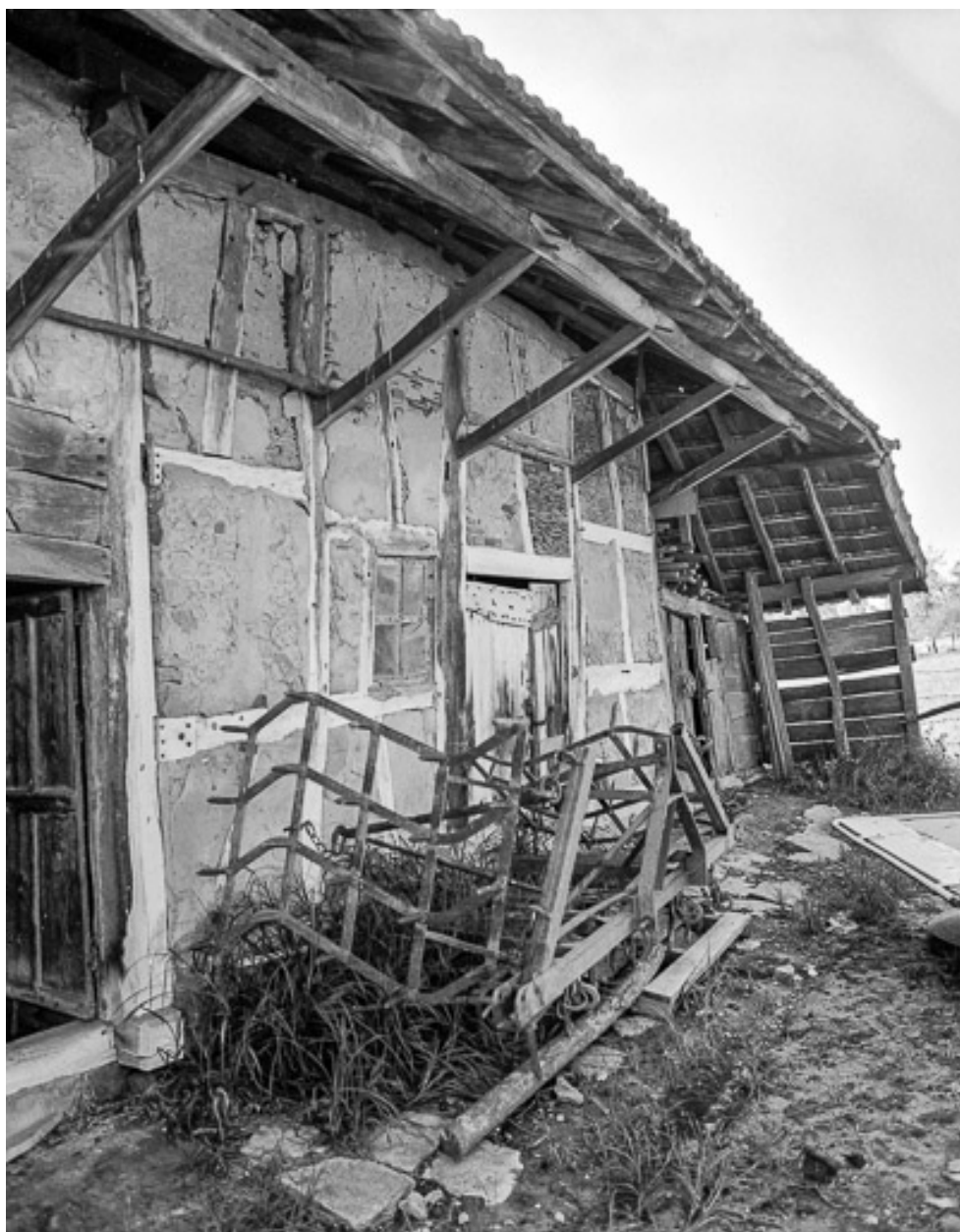
Façade antérieure : partie droite.
