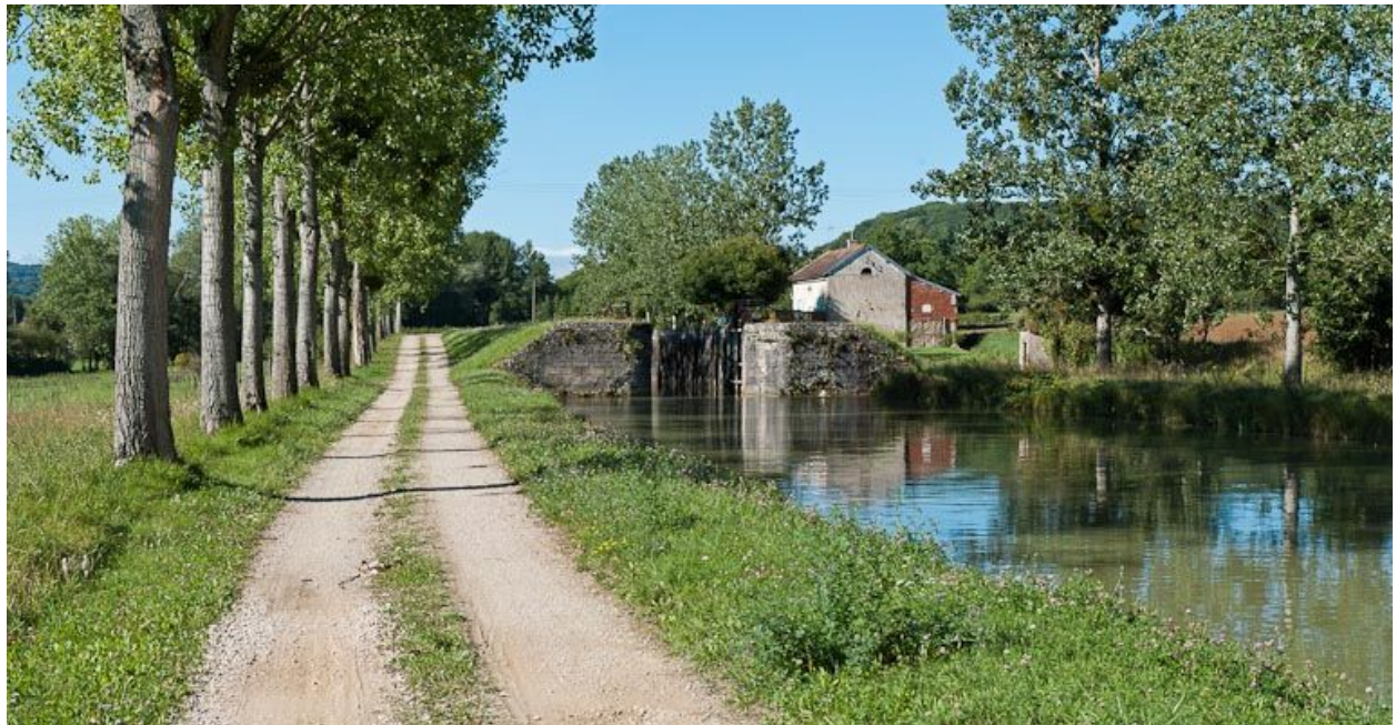
Vue du site d'écluse depuis l'aval.
