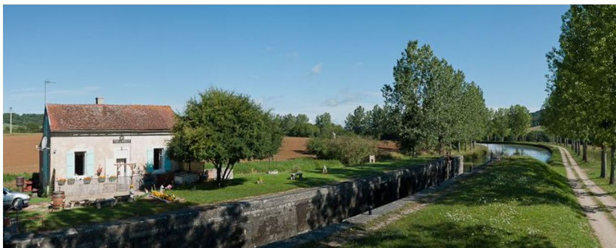
Vue d'ensemble du site d'écluse.
