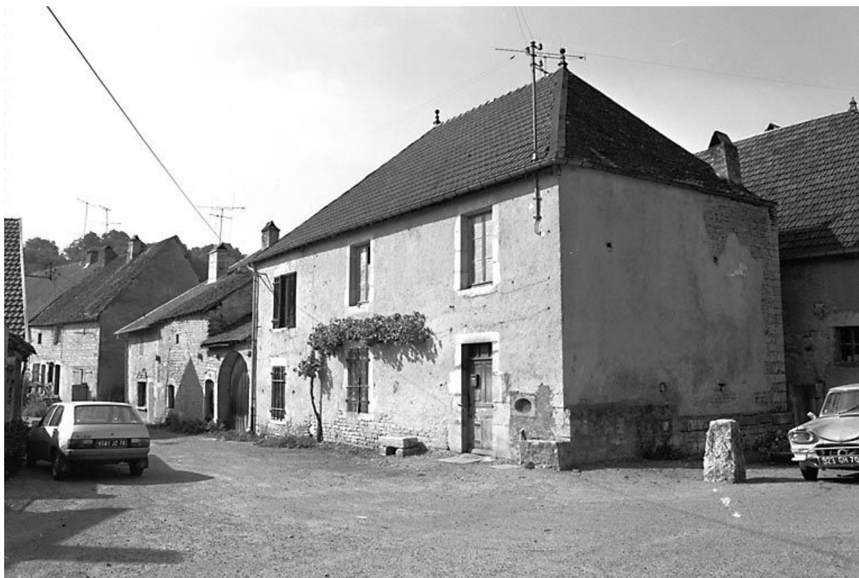
Vue d'ensemble de l'habitation.
