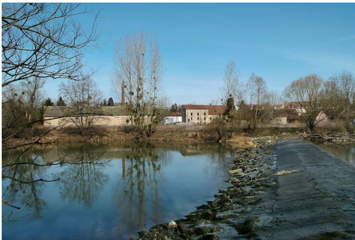
Barrage lié aux moulins de Branges.
