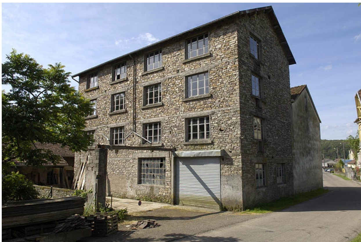
Extension orientale de l'atelier de fabrication.
