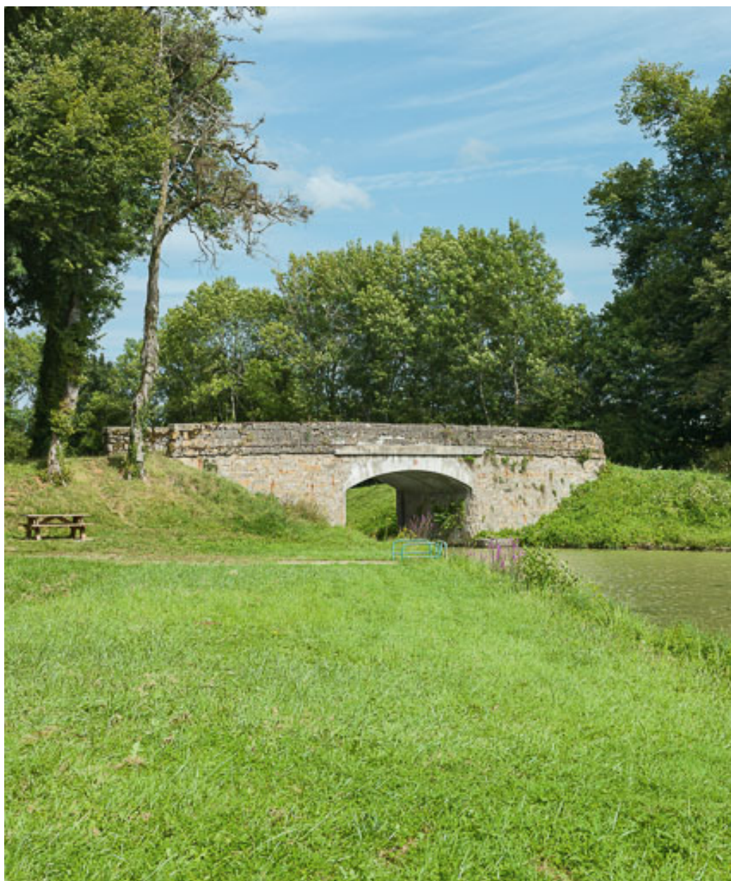
Vue d'ensemble du pont.
