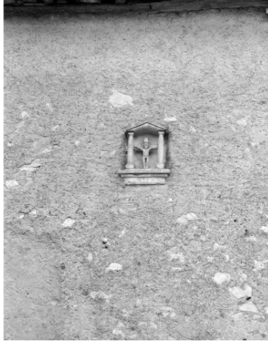
Détail de la façade : Christ en croix daté 1871. Phot. Bernard Lardière IVR43_19782500249X
