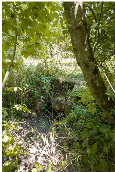
Vue de l'aqueduc.
