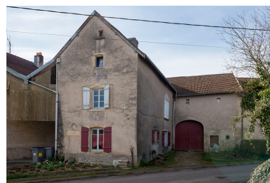
Ferme en équerre, rue du Bac. Phot. Jérôme Mongreville IVR43_20187000168NUC4A
