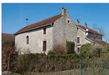
La chapelle, vue de trois-quarts. Phot. Jérôme Mongreville IVR43_20187000157NUC4A
