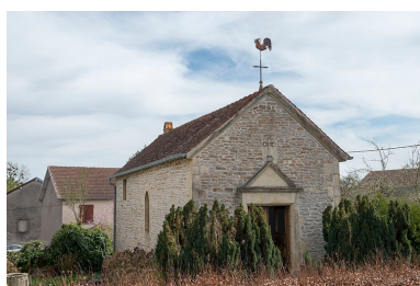
La chapelle. Phot. Jérôme Mongreville IVR43_20187000171NUC4A
