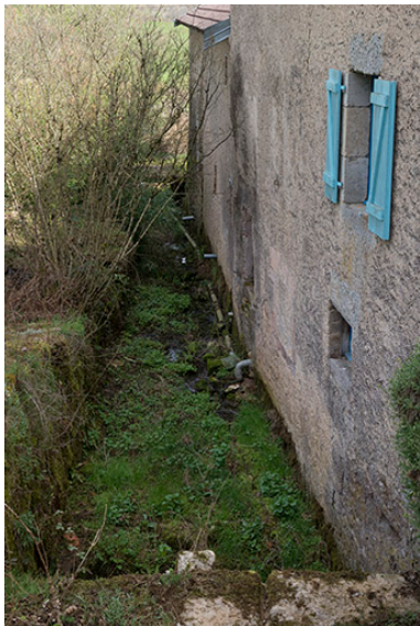
Bief de dérivation, moulin Guyot. Phot. Jérôme Mongreville IVR43_20187000159NUC4A
