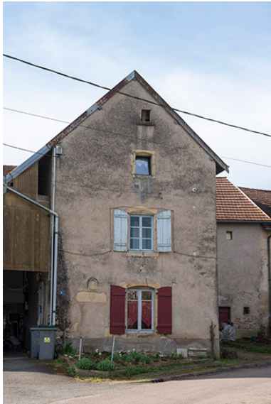
Détail sur les baies du mur pignon. Phot. Jérôme Mongreville IVR43_20187000166NUC4A
