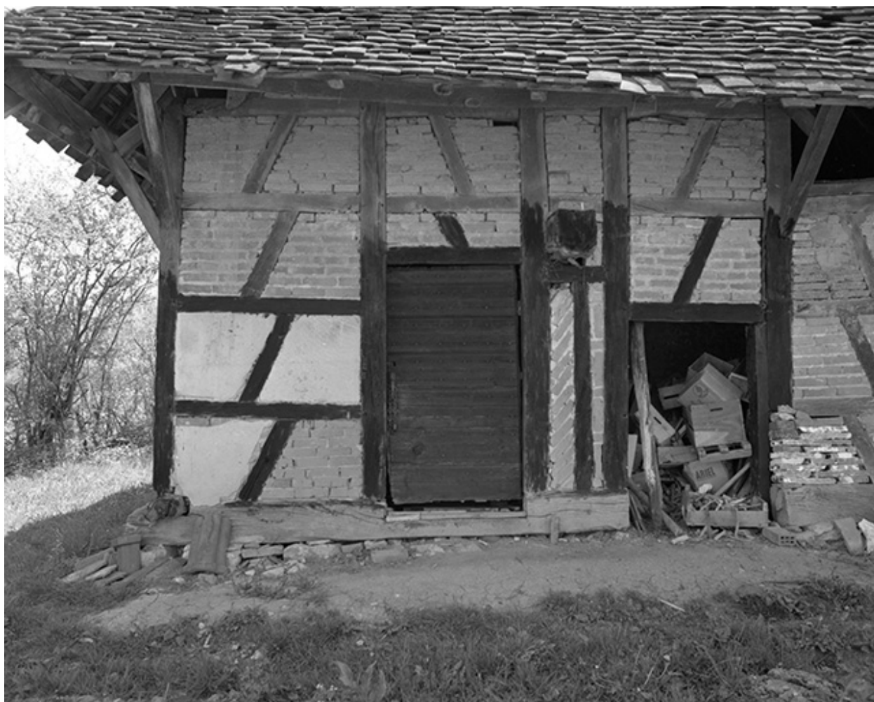
Ferme cadastrée 1969 AL 137 : vue du colombage.
