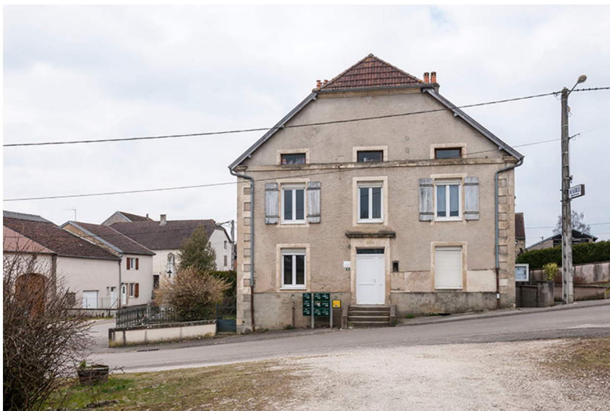
Vue sur la façade principale.
