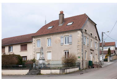
Vue d'ensemble. Phot. Jérôme Mongreville IVR43_20167000215NUC4A
