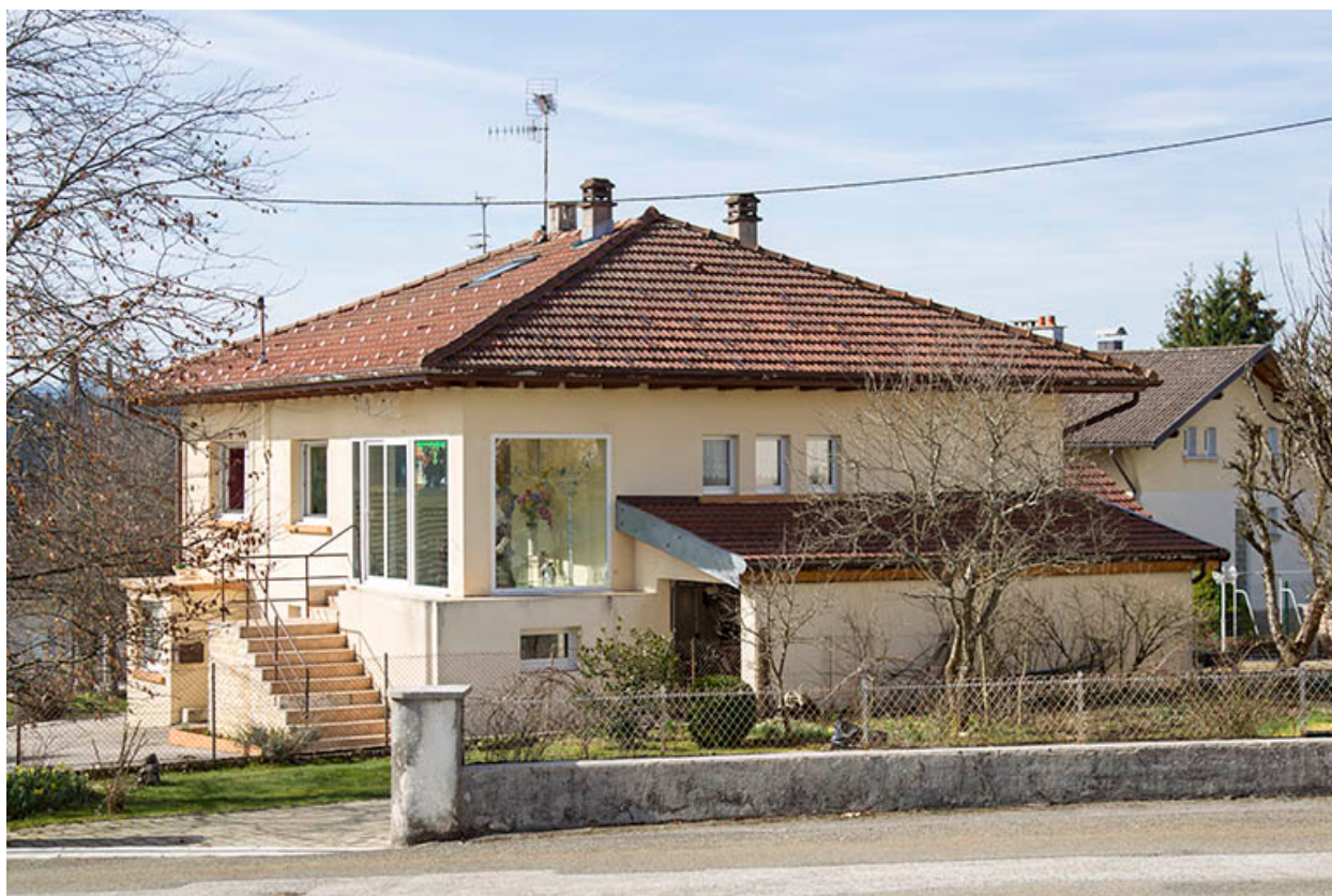
Façades antérieure et latérale droite.
