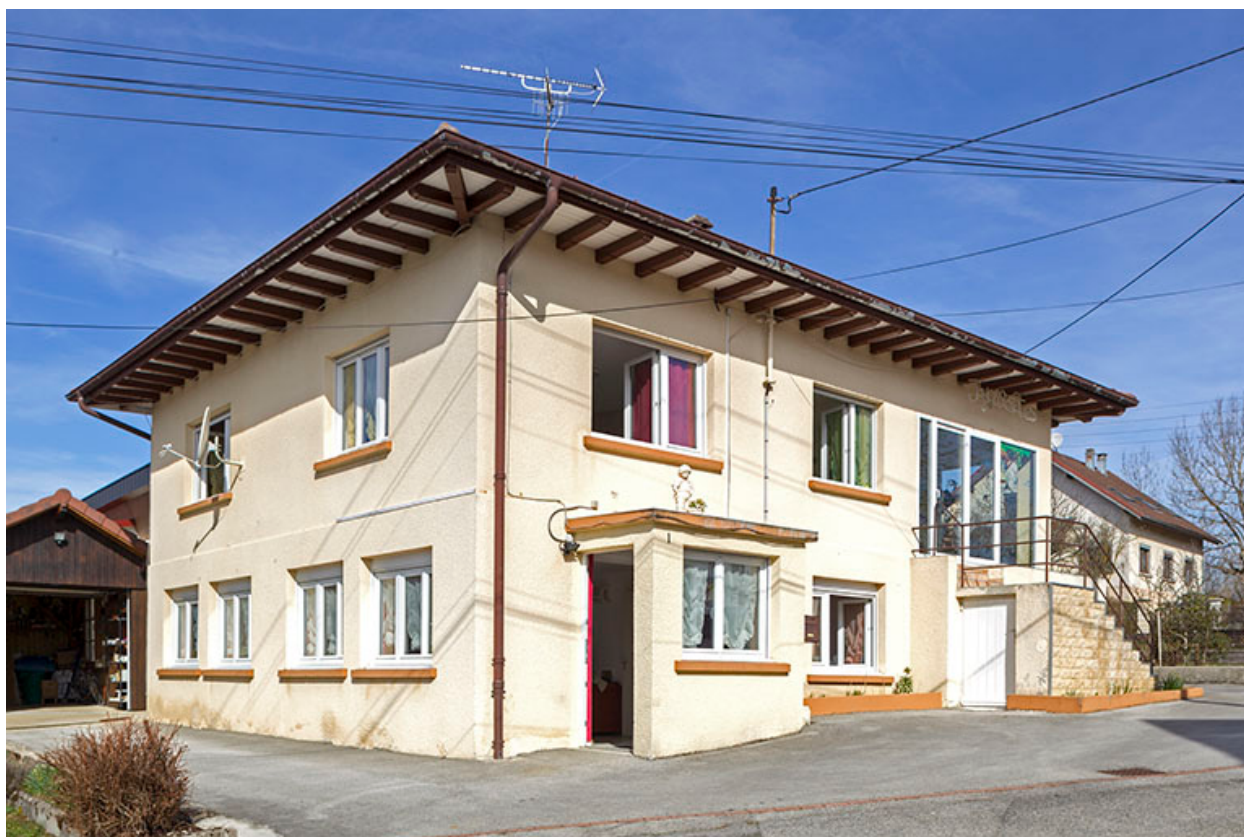
Façades antérieure et latérale gauche.
