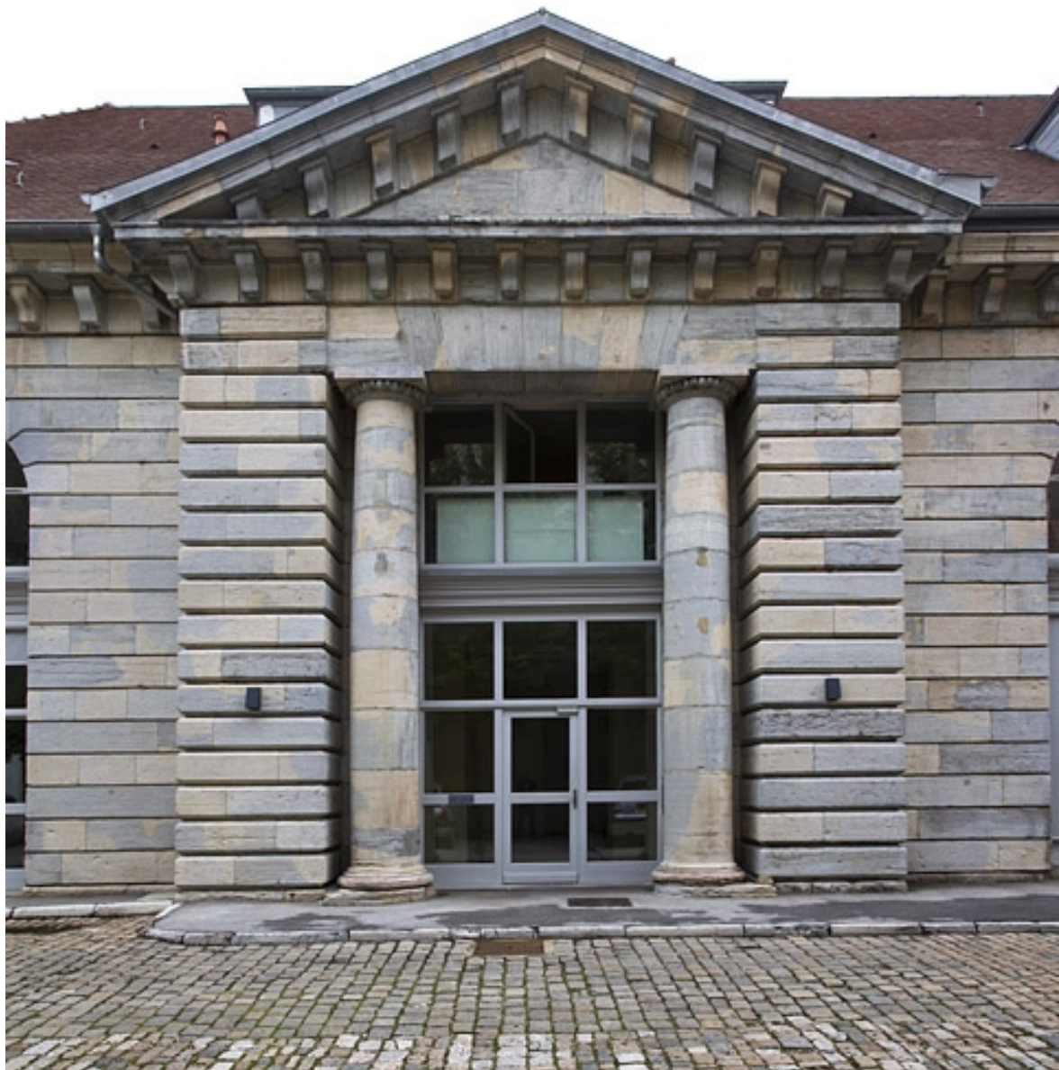
Orangerie : détail de l'avant-corps central.
