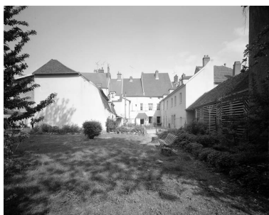
Façade postérieure : vue éloignée. Phot. Yves Sancey IVR43_19897000254V
