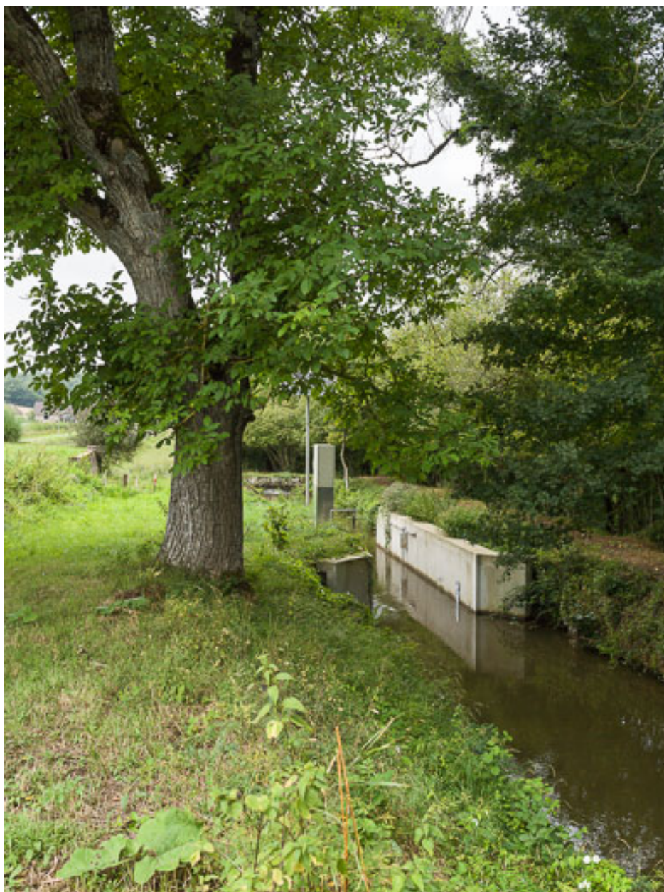
Vue de la rigole d'alimentation.
