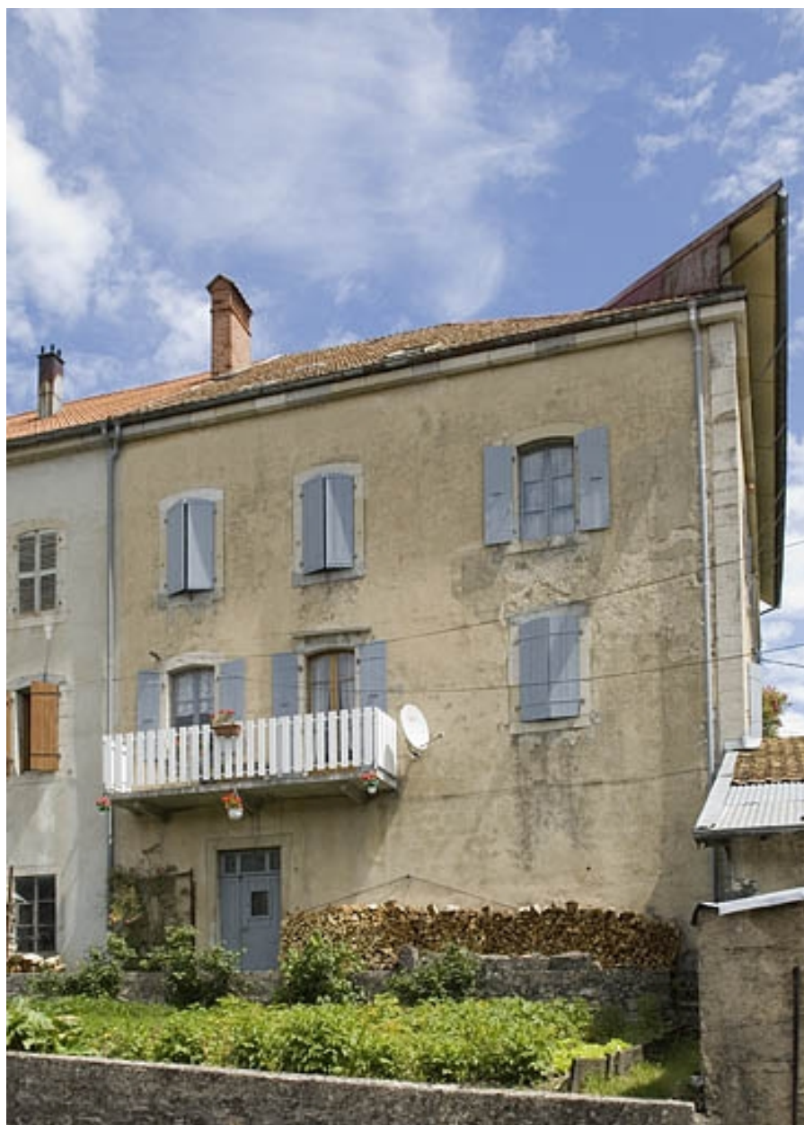
Façade postérieure de la partie sud.
