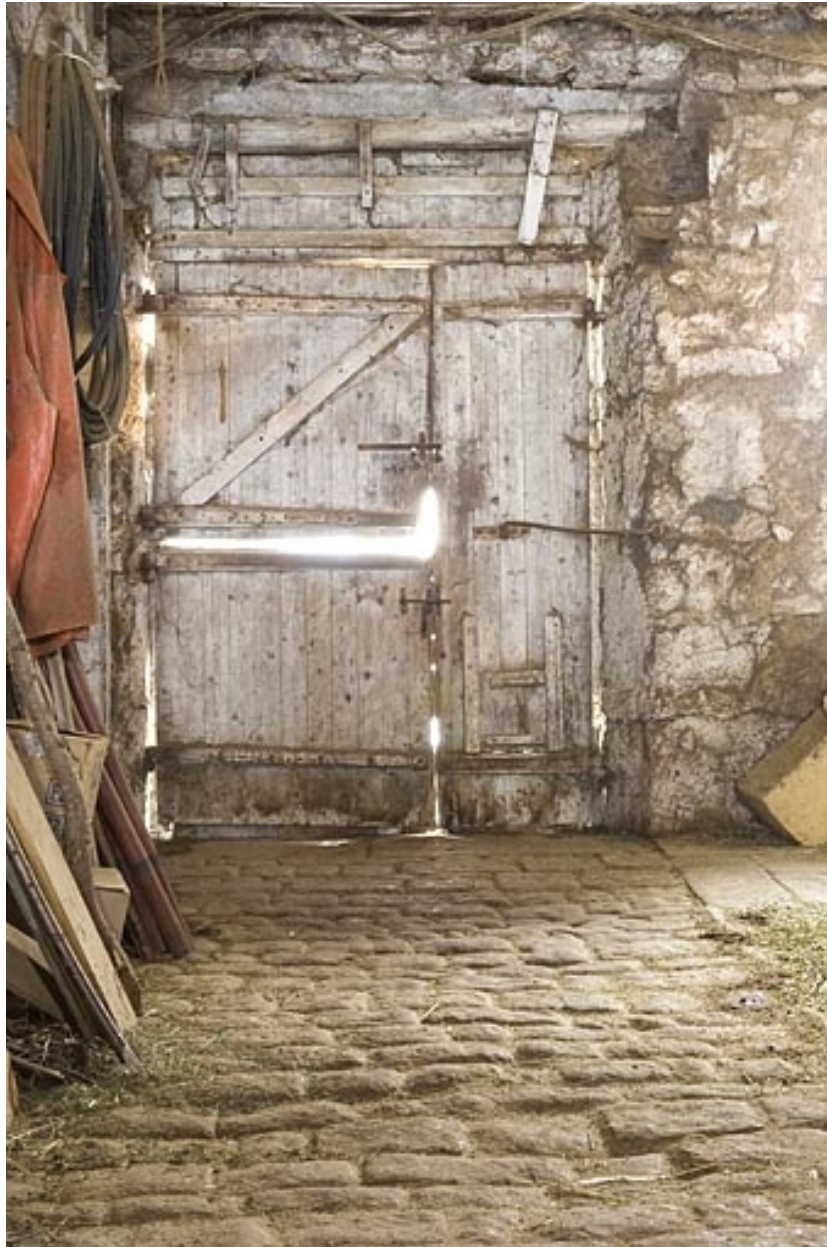
Etable : la porte vue de l'intérieur.
