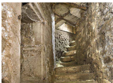
Escalier en pierre. Phot. Jérôme Mongreville IVR43_20092500020NUC2A
