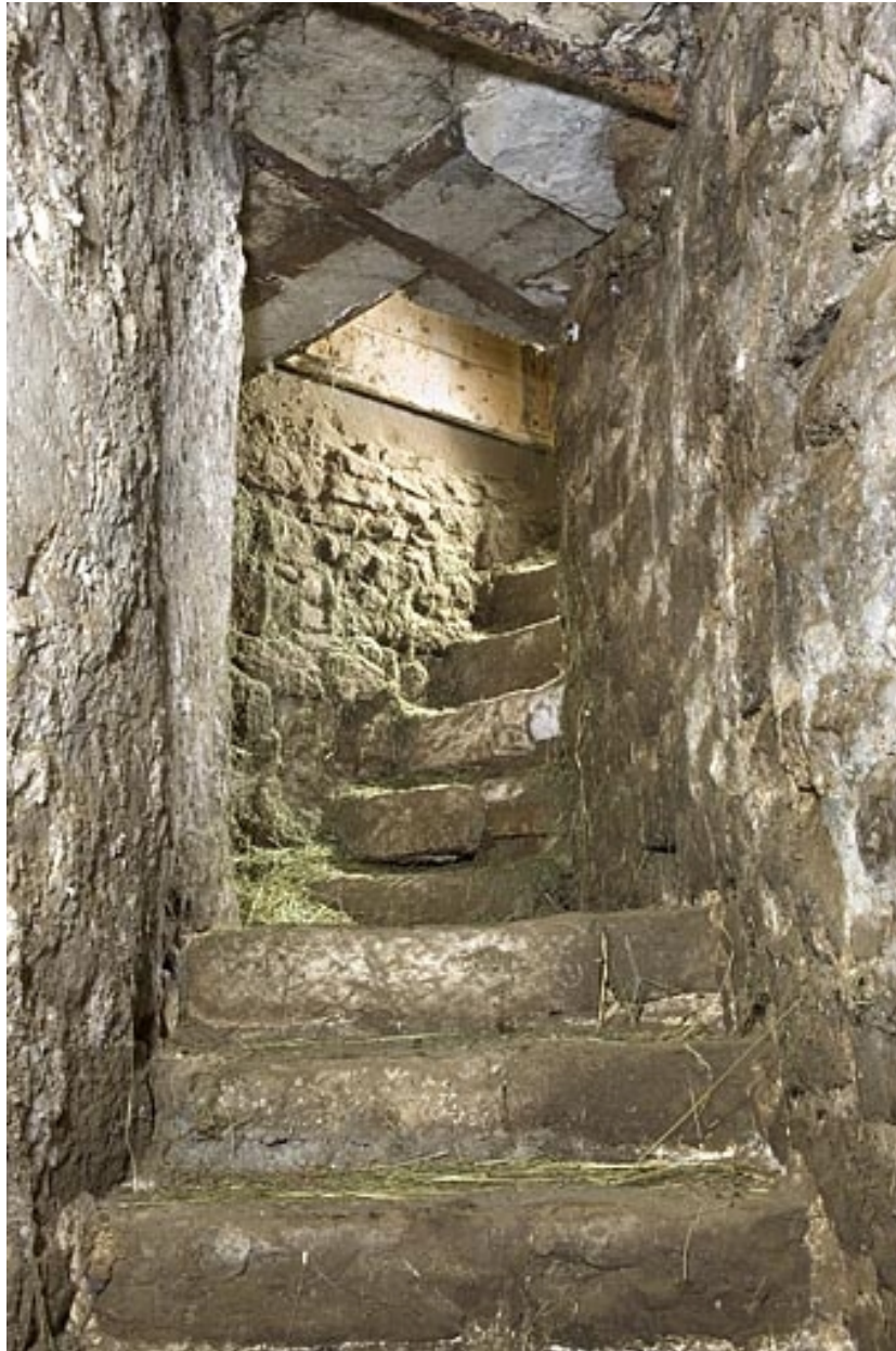
Escalier en pierre (cadrage vertical).
