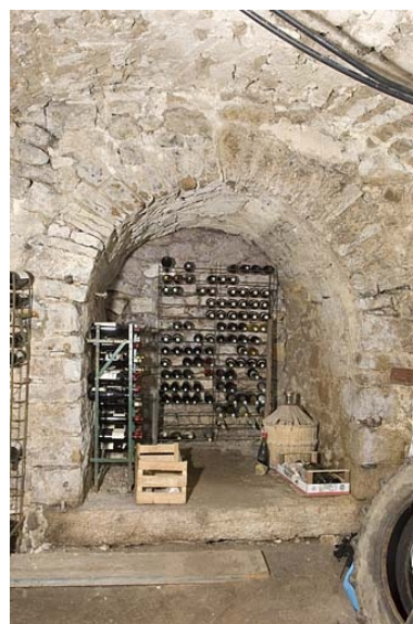
Sous-sol ("cave") : niche. Phot. Jérôme Mongreville IVR43_20092500025NUC2A
