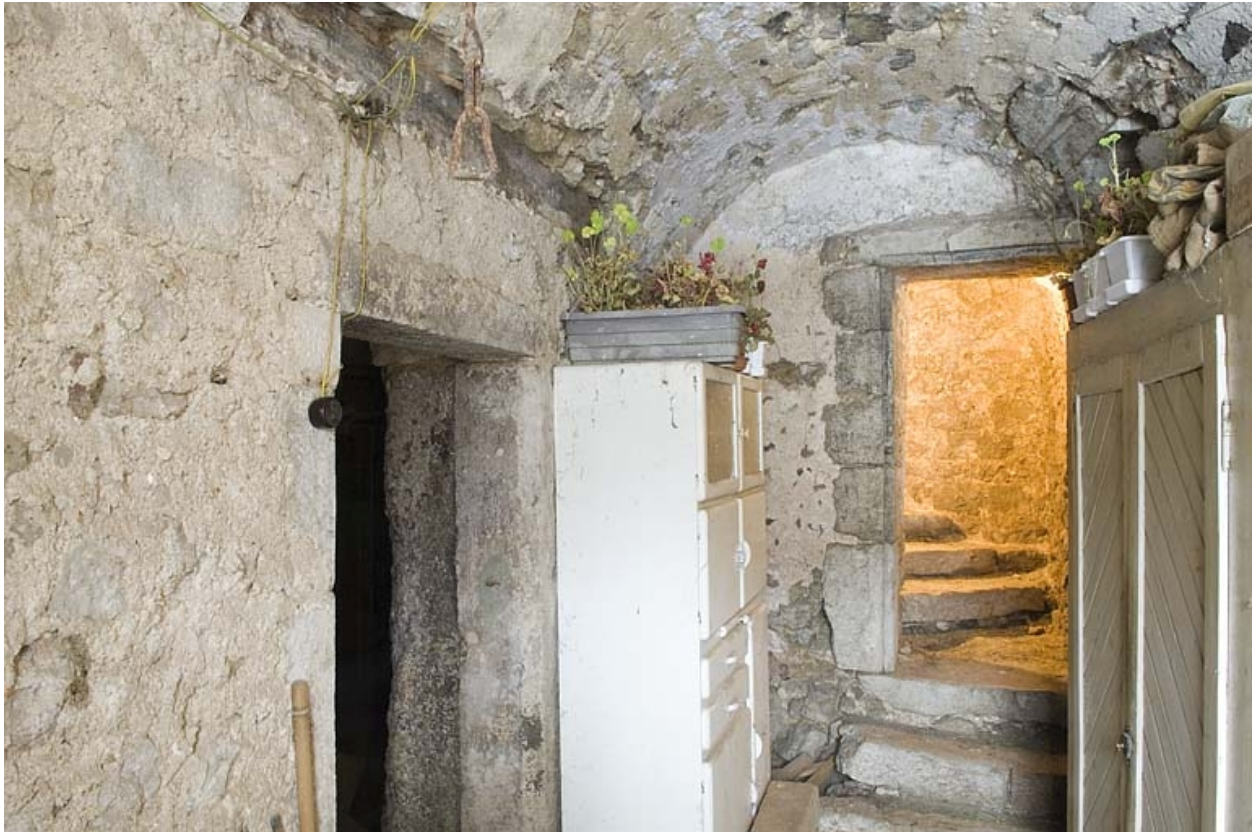
Couloir et départ de l'escalier en pierre.
