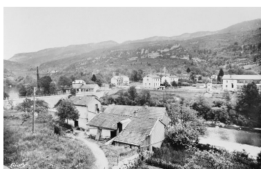
Chassal (Jura). Vue générale. Phot. Jérôme Mongreville IVR43_19903900322X
