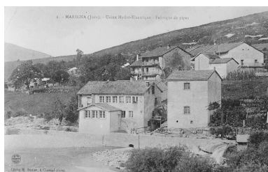
Marigna (Jura). - Usine Hydro-Electrique - Fabrique de pipes. Phot. Jérôme Mongreville IVR43_19903900324X
