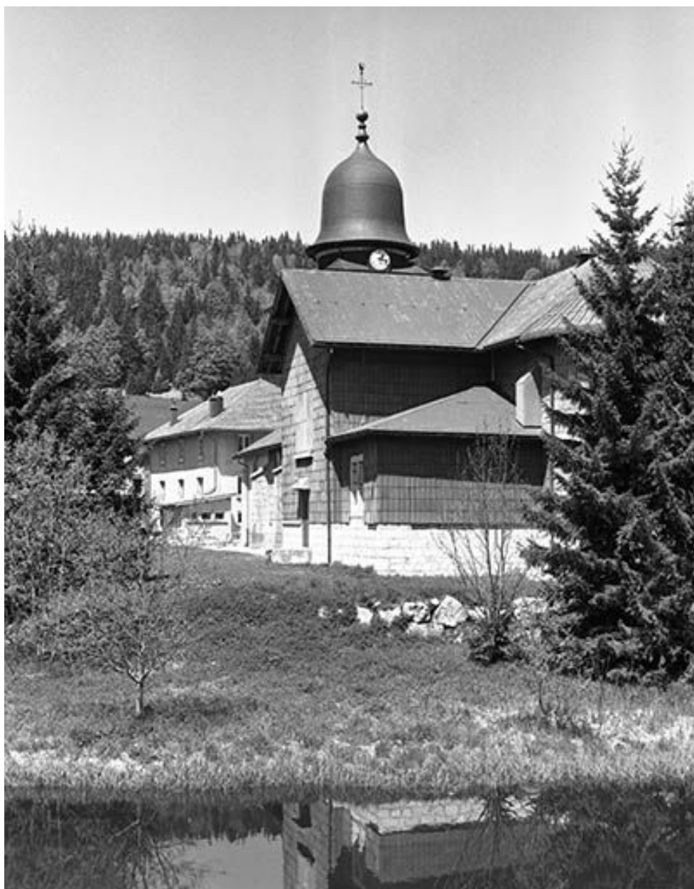
Vue de l'église depuis le sud.
